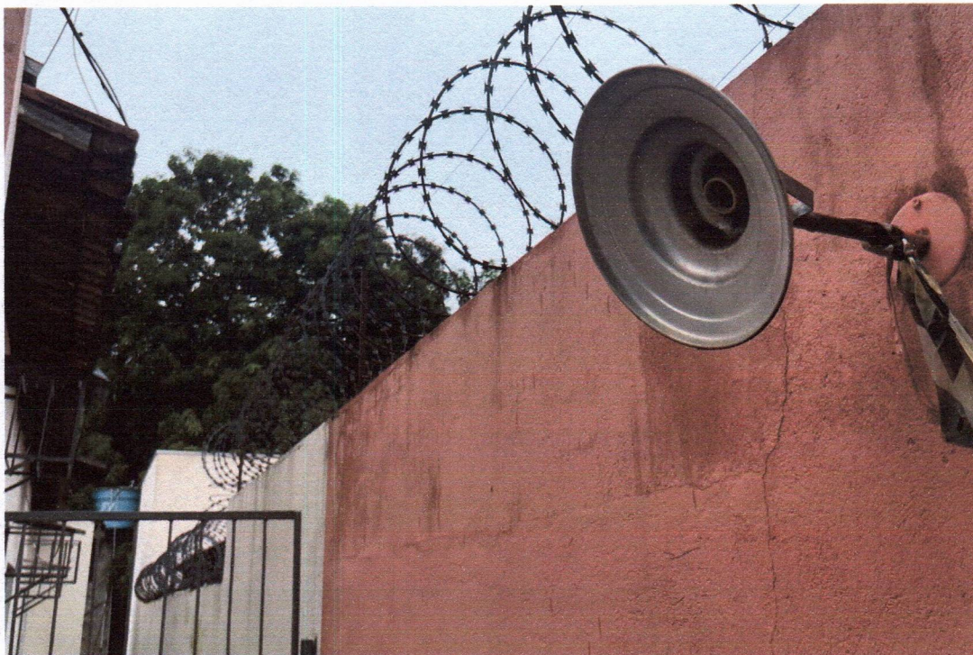
Imagem 06: muro lateral com concertina e iluminação externa para a calçada frontal.
