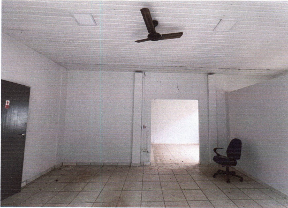
Imagem 22: Sala 01 – vão de acesso à sala 02.
