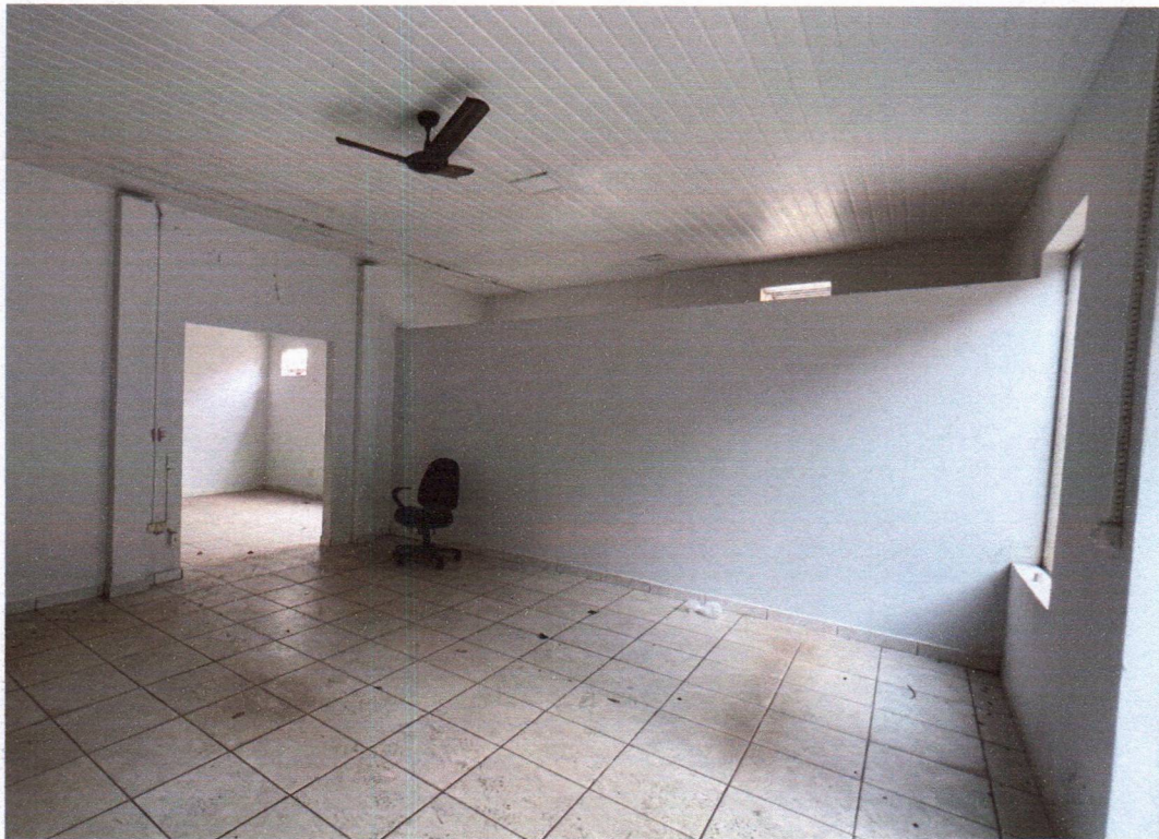
Imagem 08: sala 01 – vão de acesso à sala 02, piso em cerâmica e forro em PVC.
