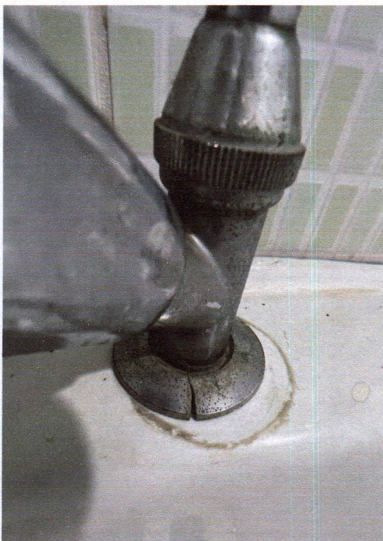
Imagens 16 e 17: Lavabo 02 – torneira com avaria, vazamento no lavatório.
