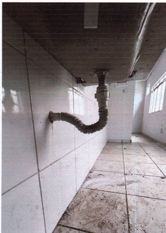
Imagens 27 e 28: Cozinha/Copa – encanação de esgoto da pia necessitando de melhor instalação
