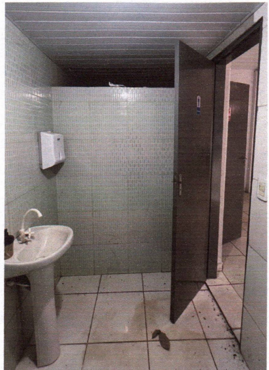
Imagens 12 e 13: lavabo 01 – maçaneta da porta com avaria; revestimentos cerâmicos e forro em PVC.
