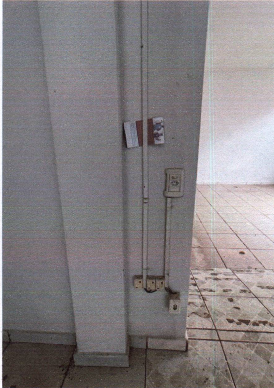
Imagens 10 e 11: sala 01 – tomadas e fiações em canaletas; lavabo 01.
