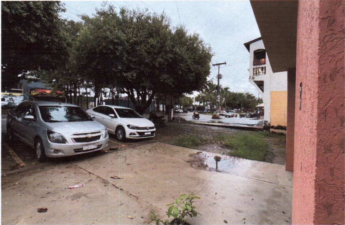
Imagem 03: Vista da fachada principal para a Avenida Xingu.
