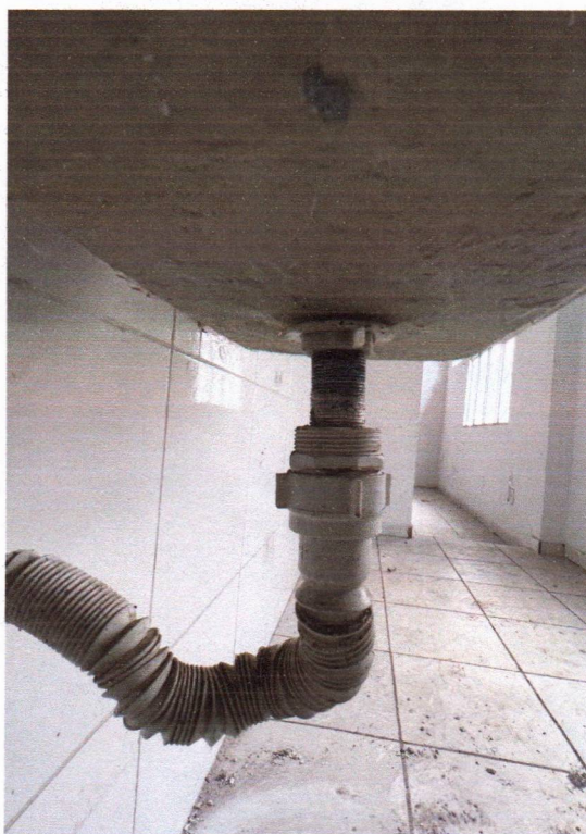
Imagens 27 e 28: Cozinha/Copa – encanação de esgoto da pia necessitando de melhor instalação
