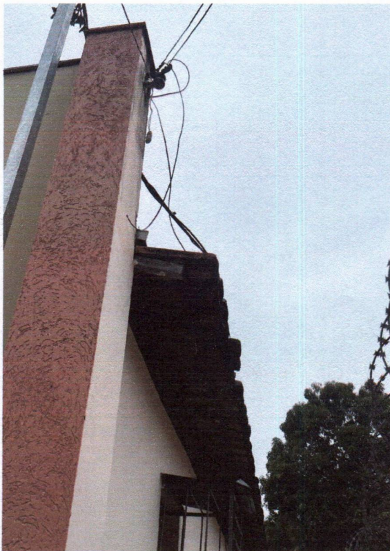
Imagens 04 e 05: beiral lateral (fições expostas); padrão e corredor externo lateral.
