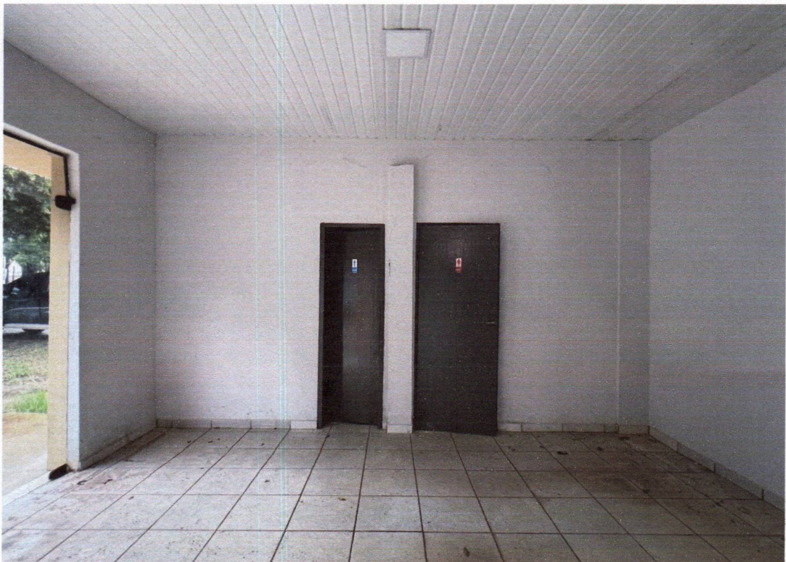
Imagens 20 e 21: Sala 01 – vista das portas de acesso aos lavabos.
