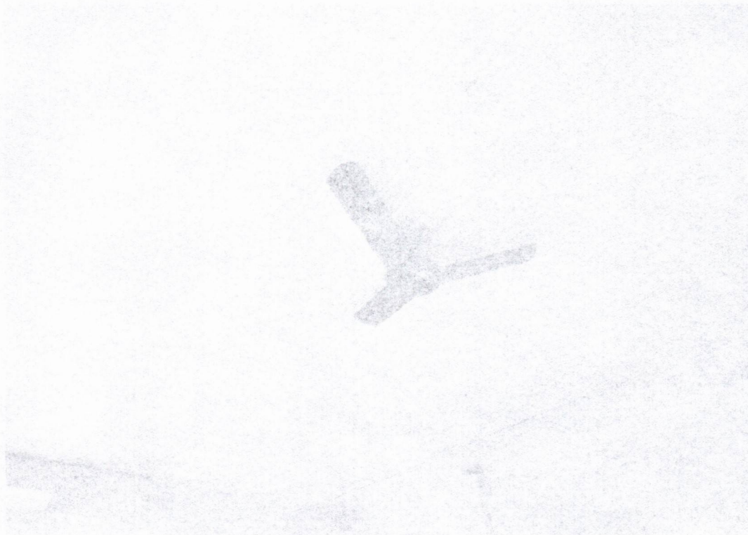
Foto 02 - Sala 01 - Ventilador de teto.
