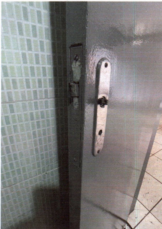
Imagens 12 e 13: lavabo 01 – maçaneta da porta com avaria; revestimentos cerâmicos e forro em PVC.
