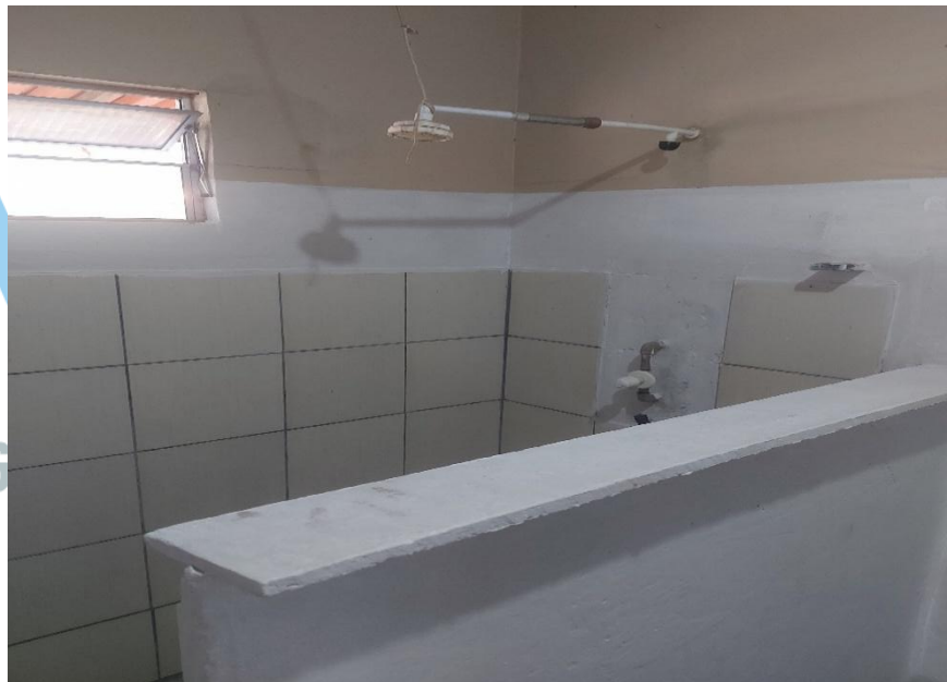
Figura 6: Vista do banheiro. 02.
