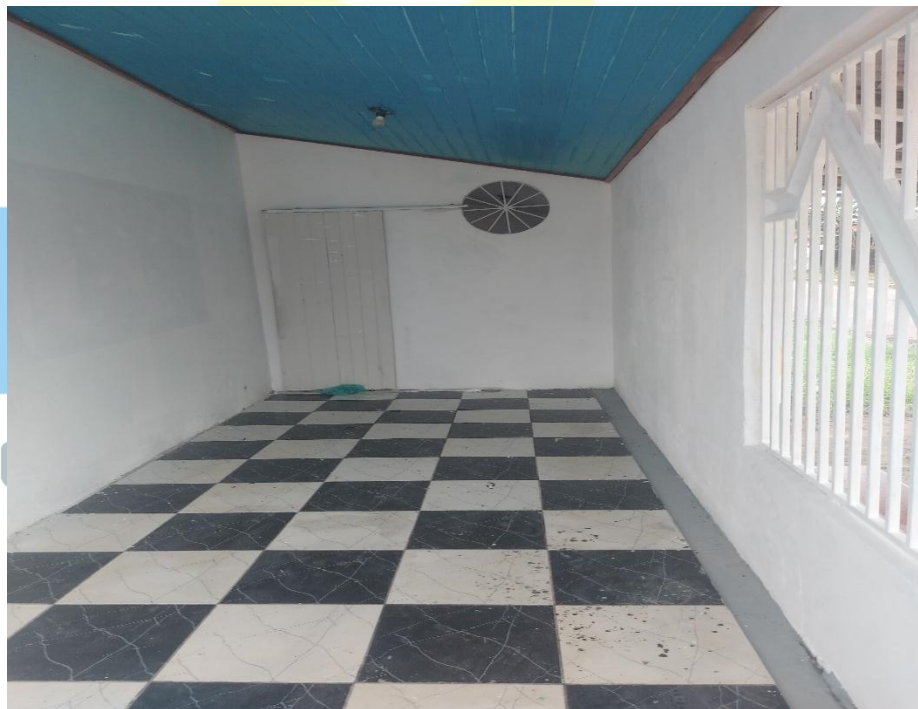
Figura 10: Vista da garagem.
