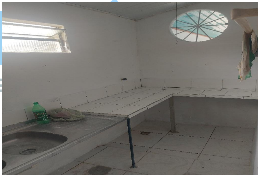
Figura 4: vista da cozinha 02.
