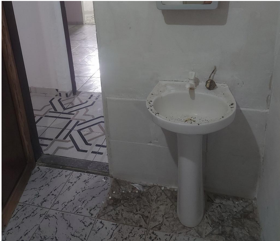
Figura 7: Vista do banheiro. 02.
