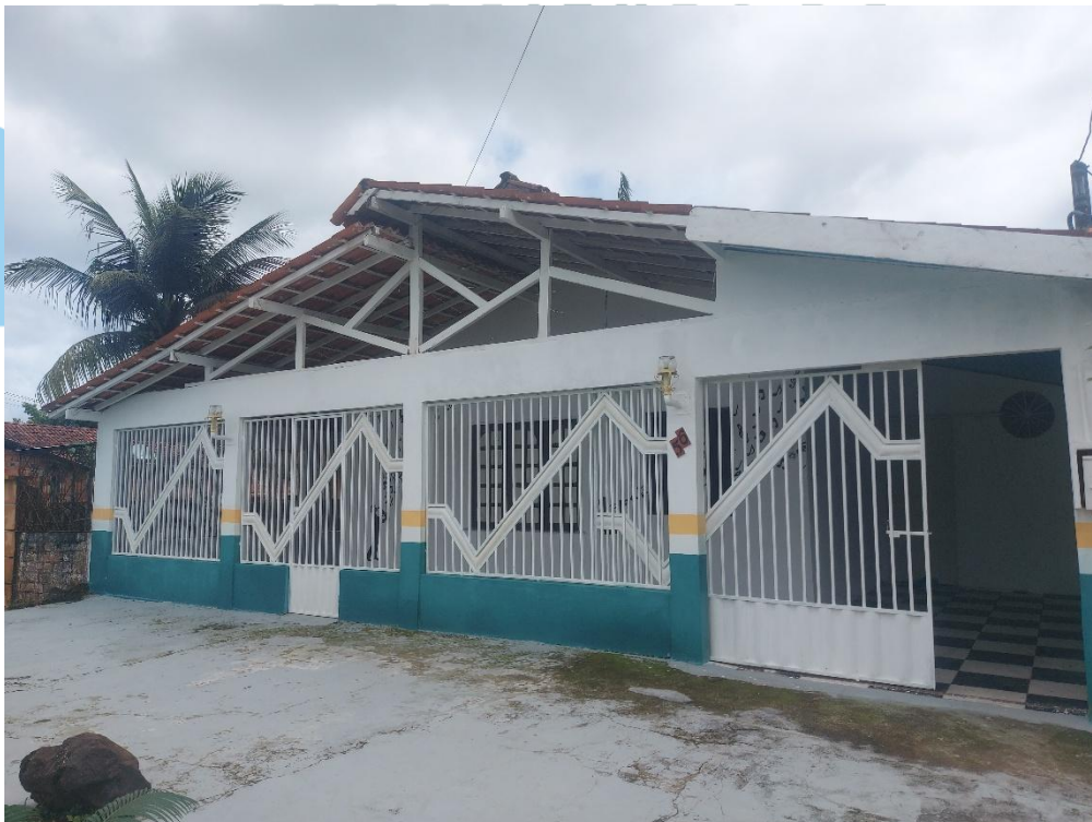
Figura 8: Vista da fachada frontal.
