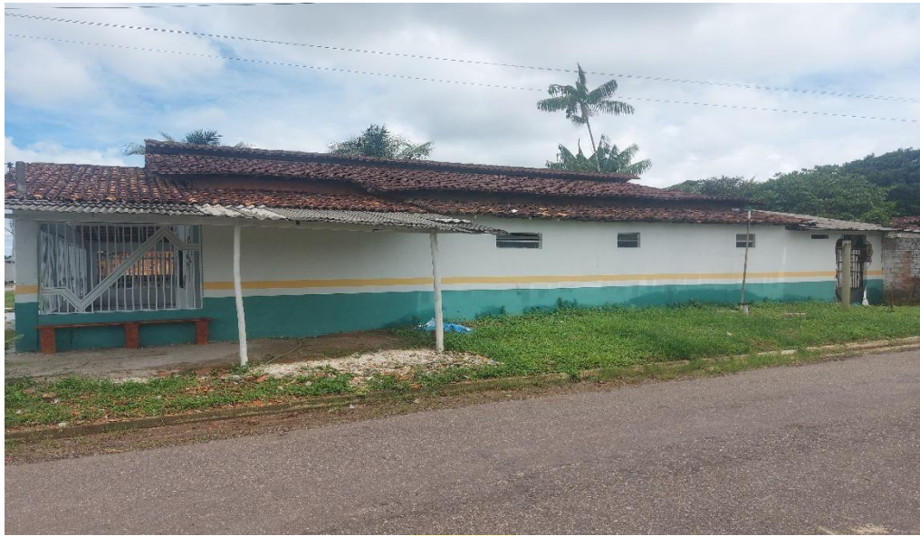
Figura 9: vista da fachada esquerda.
