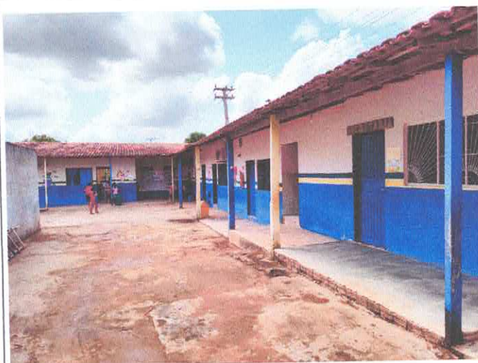
Imagem 04 – Vista frontal das salas de aula
