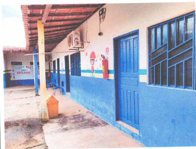
Imagem 03 – Vista frontal das salas de aula
