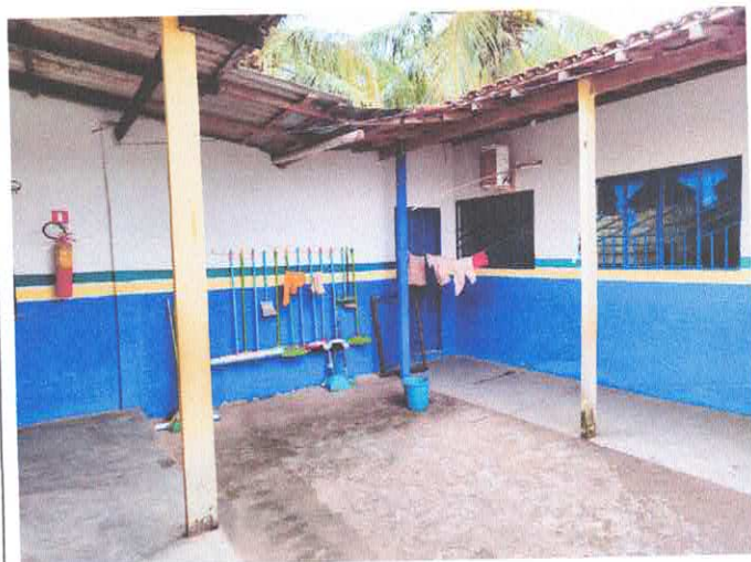
Imagem 08 – Pátio aberto 02 e vista salas de aula
