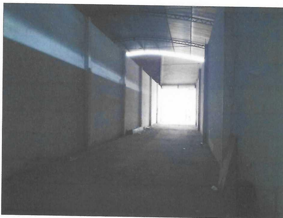
Vista interna do depósito 01, entrada da edificação.
