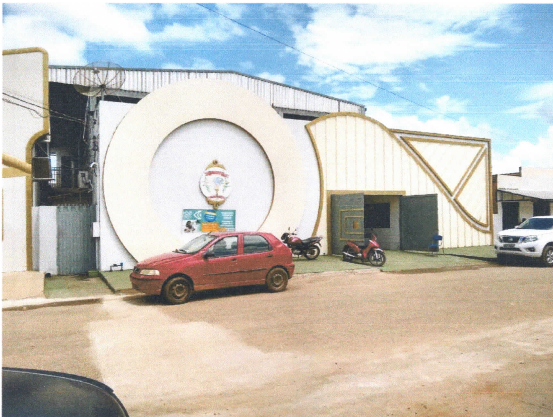
Foto 1 – Fachada do imóvel.
