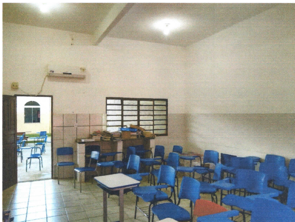
Foto 5 – Sala de aula
