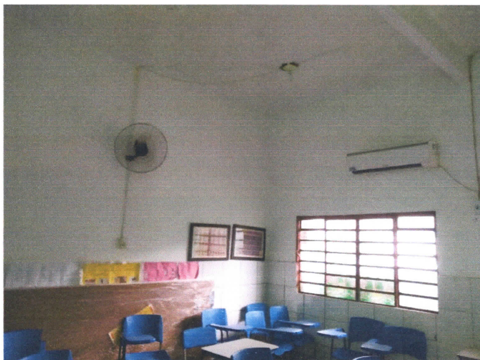
Foto 13 – Sala de aula
