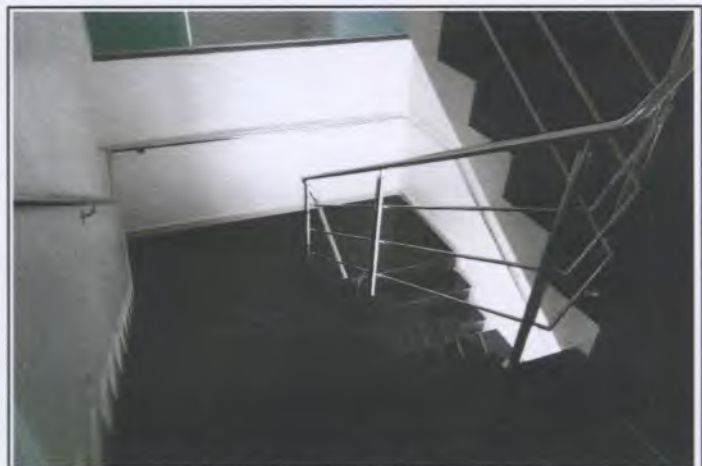
Foto 06: Escada de acesso à pav. Superiores
