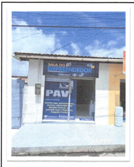
Foto 01: Vista principal do prédio.
