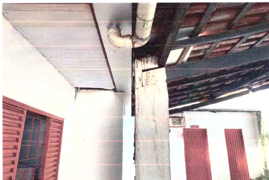
Figura 17 – Infiltração aparente
