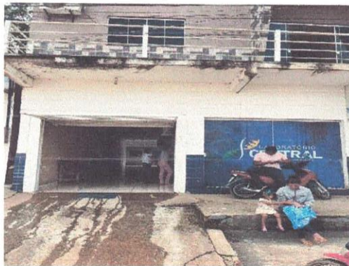
Imagem 1 - Fachada do imóvel
