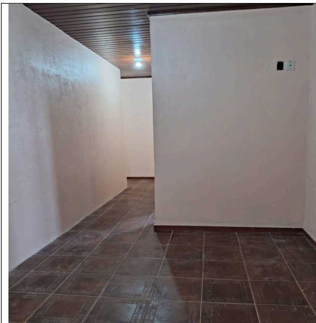
Foto 09: Corredor de circulação.
