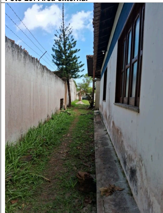
Foto 31: Corredor de circulação da área externa.
