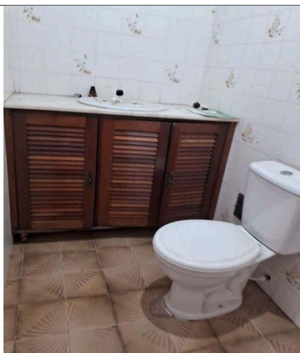
Foto 08: Banheiro existente no Salão principal.
