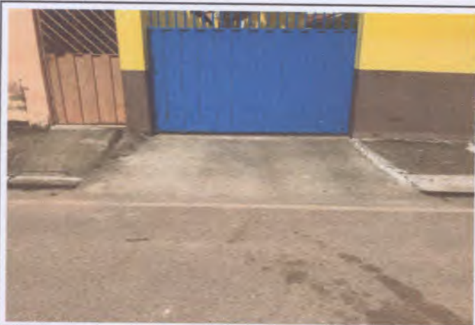
Foto 03: Rampa localizada na entrada principal atendendo as normas de acessibilidade.
