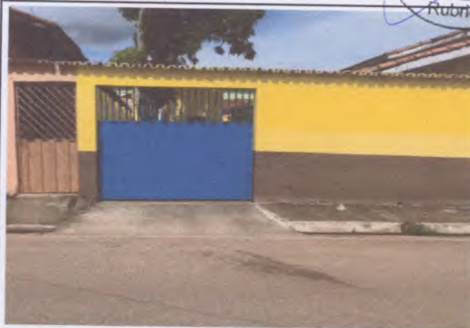
Foto 02: Rampa localizada na entrada principal atendendo as normas de acessibilidade.
