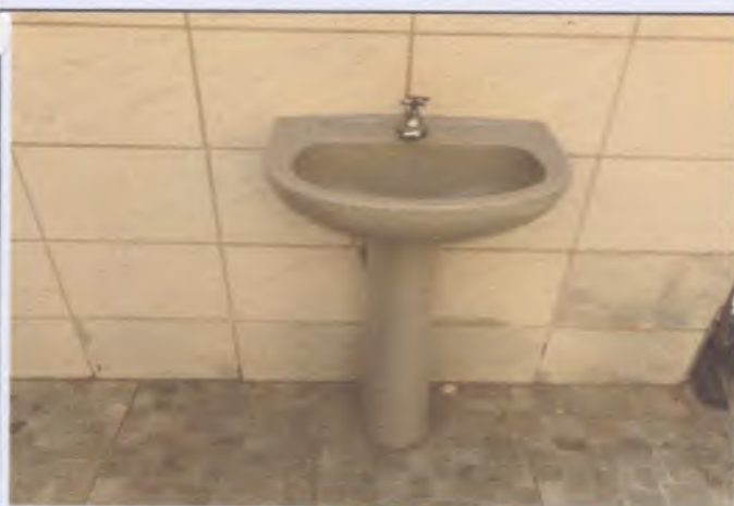
Foto 51: Pia localizada na parte dos fundos do imóvel.
