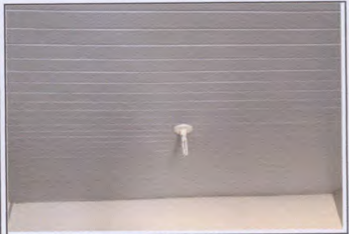
Foto 46: Forro PVC instalado no auditório.
