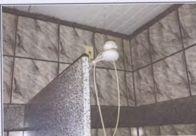
Foto 40: Banheiro localizado no interior da sala 05.
