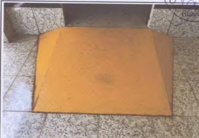
Foto 08: Rampagem acessível que permite o acesso de cadeirantes ao interior da recepção.
