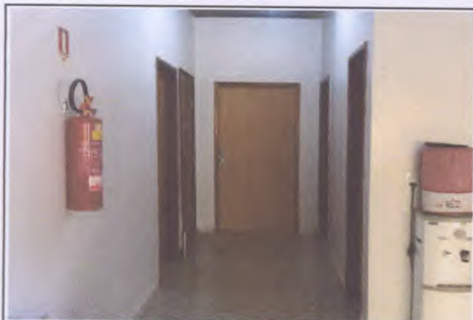
Foto 13: Corredor que dá acesso a sala 01, sala 02, sala 03, depósito 01, e banheiro PCD.
