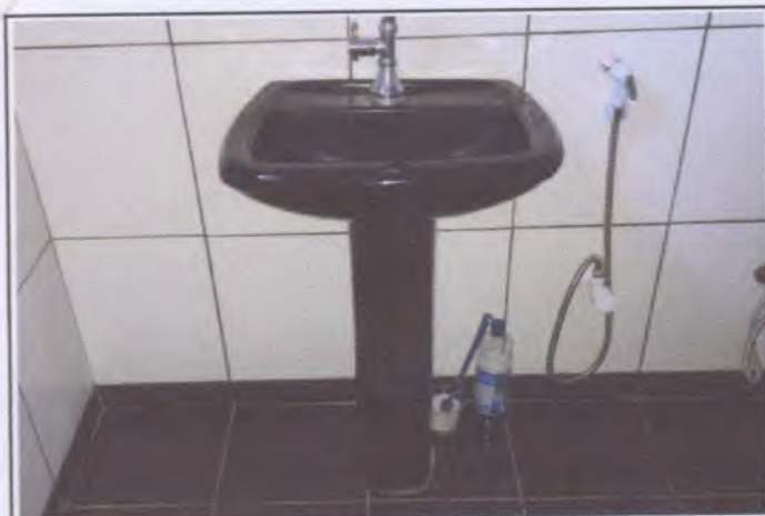
Foto 33: Banheiro localizado no interior da sala 04.
