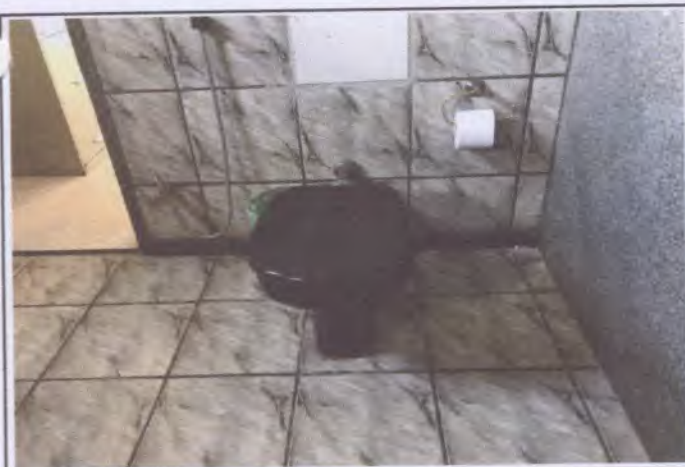
Foto 39: Banheiro localizado no interior da sala 05.
