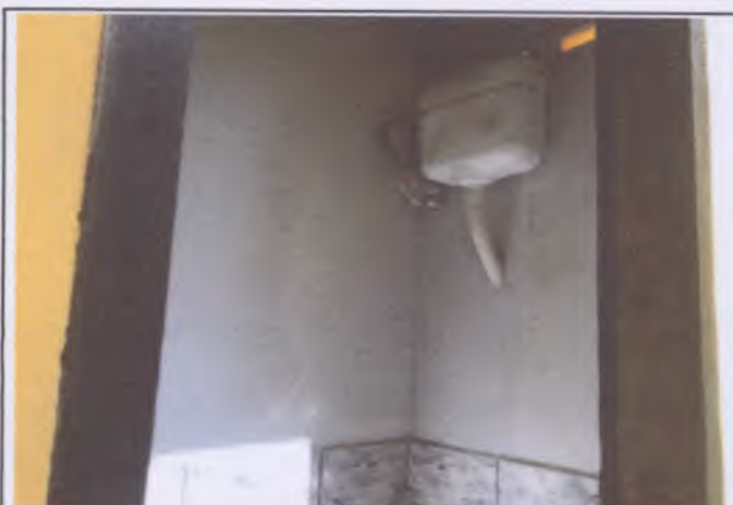
Foto 50: Banheiro localizado nos fundos do imóvel.
