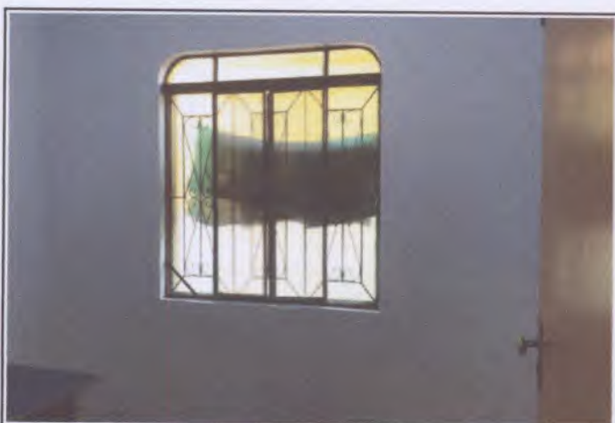
Foto 18: Esquadria de mix de ferro e vidro, localizada na sala 01.
