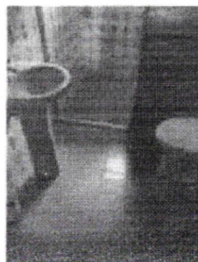
Foto 10 – Banheiro da suite.
