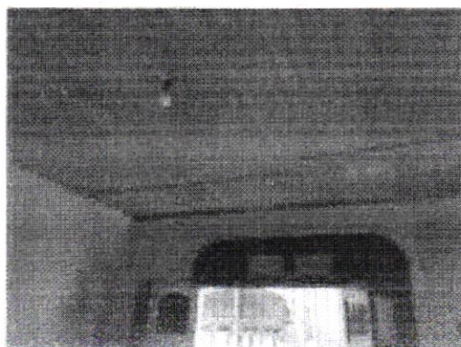
Foto 08 – Forro da suite
