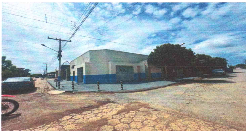
Foto 01 - Fachada Esquina: Rua 13 e Avenida 12
