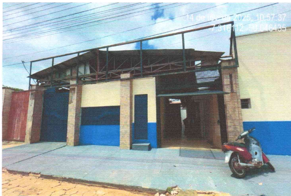
Foto 27 - Avenida 12: Acesso Lateral 2, 3 e 4
