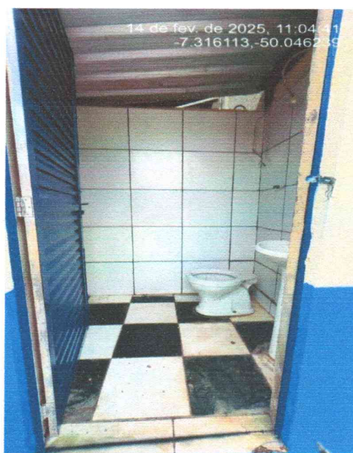
Foto 28 - Acesso 3 Wc 01: Garagem
