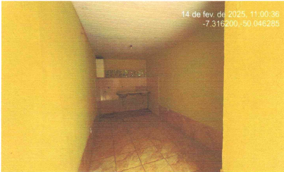
Foto 23 - Área de Serviço
