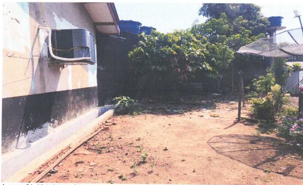
Imagem 04 - Vista Lateral Direita do Imóvel
