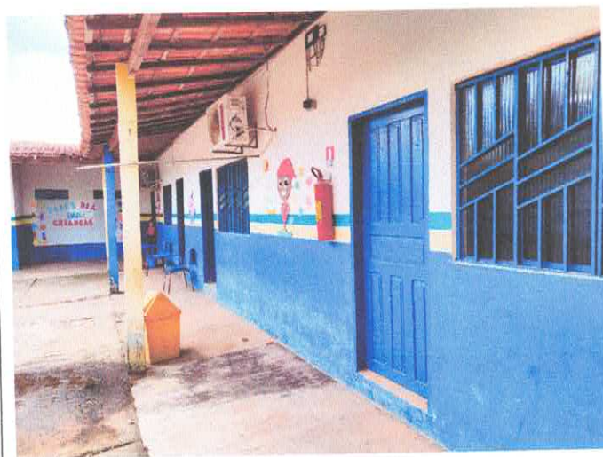
Imagem 03 – Vista frontal das salas de aula
