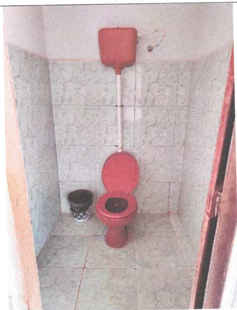
Imagem 11 – Vista interna banheiro 01
