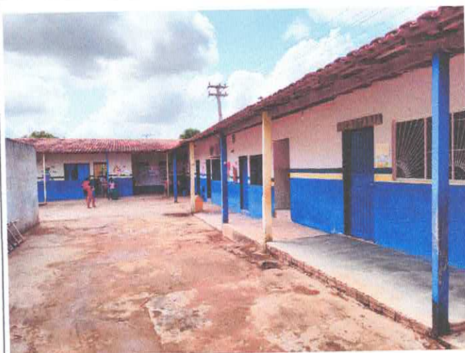
Imagem 04 – Vista frontal das salas de aula
