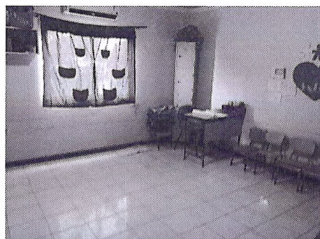
FOTO 02- SALA DE AULA
