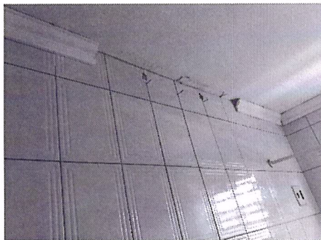
FOTO 06- FORRO DE GESSO
