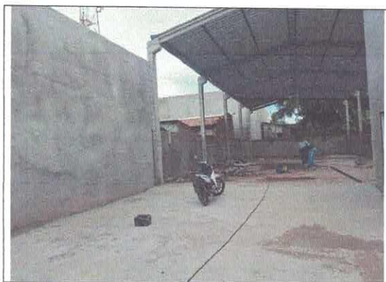
Imagem 04: Vista interna do imóvel
