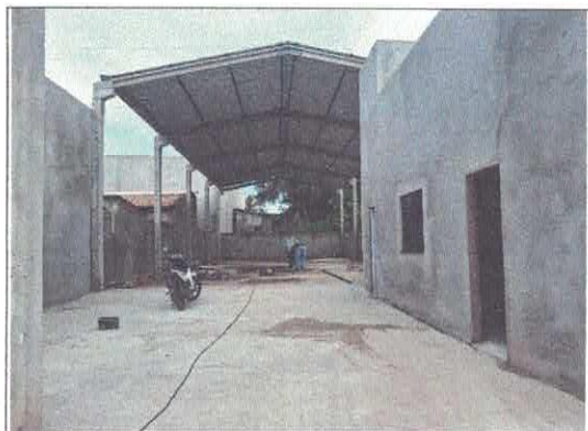
Imagem 05: Vista Interna do imóvel
