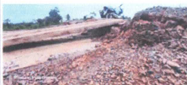
FOTO 02: Ponte na estrada do Cristal
