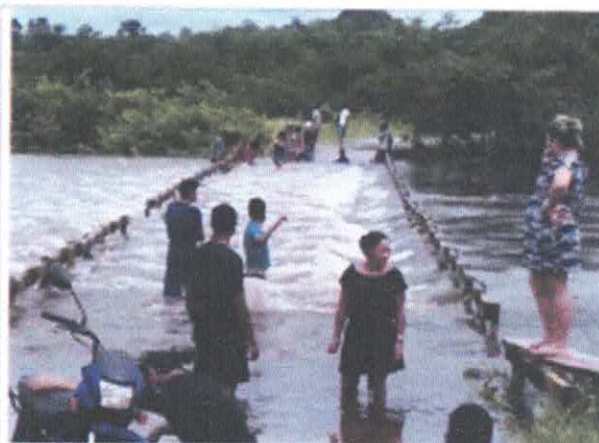
FOTO 08: Ponte do Peritoró Grande
