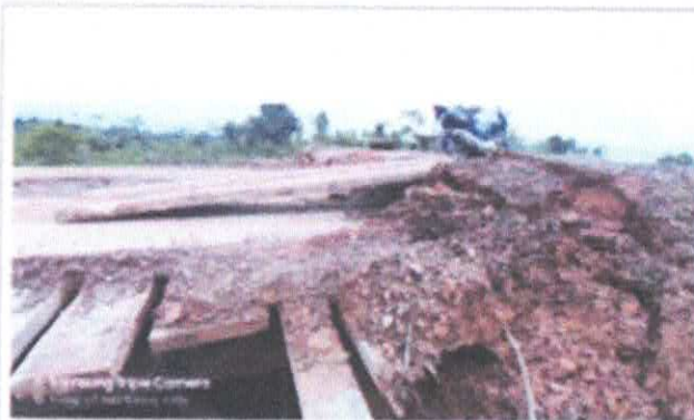
FOTO 03: Ponte na estrada do Cristal
