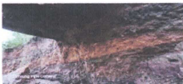
FOTO 01: Ponte na estrada do Cristal
