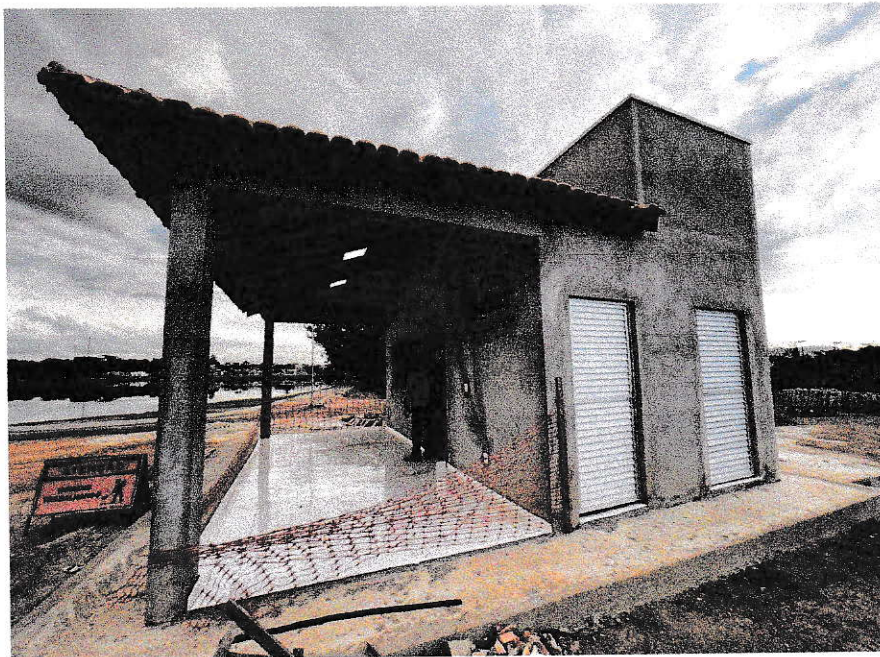
IMAGEM 5: VISTA LATERAL ESQUERDA – ACESSO AOS SANITÁRIOS
