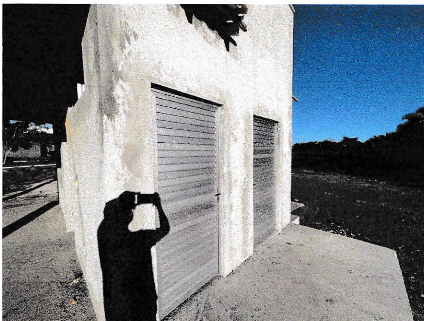
IMAGEM 5: VISTA LATERAL ESQUERDA – ACESSO AOS SANITÁRIOS
