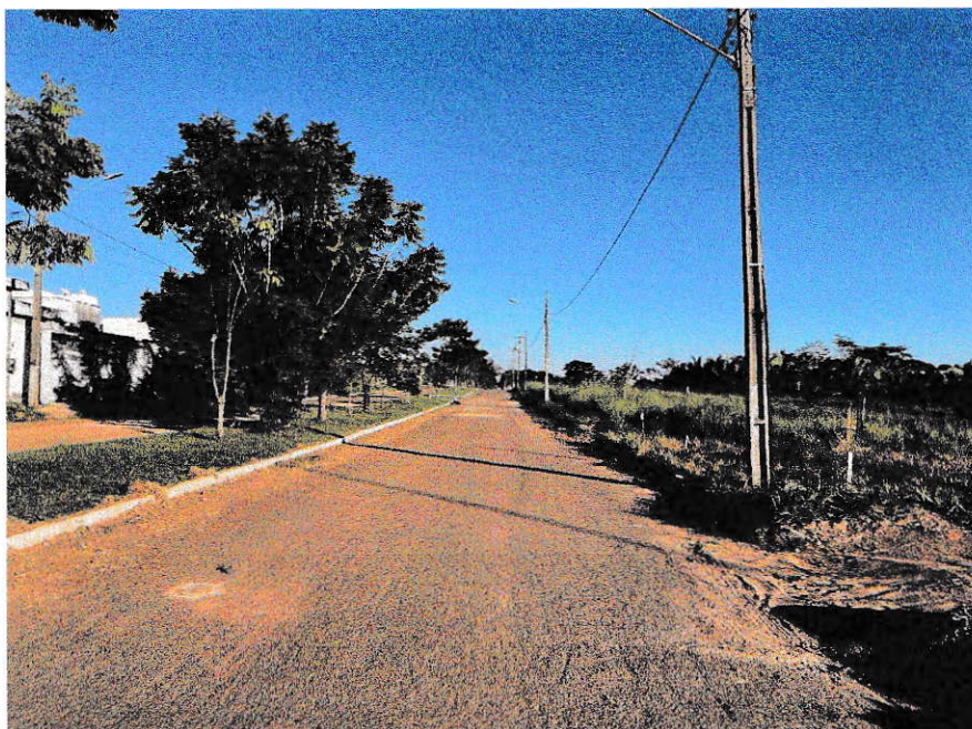
IMAGEM 2: VISTA LATERAL ESQUERDA À EDIFICAÇÃO
