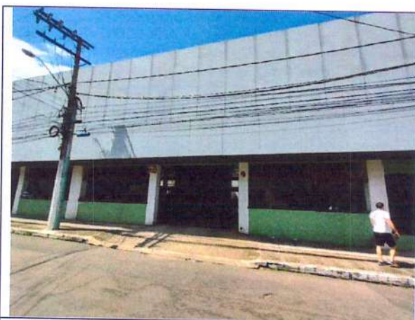
Foto 05: Entrada e saída do estacionamento/garagem
