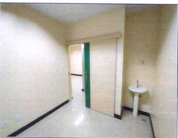
Foto 82: Anexo à sala 02
