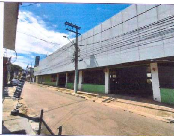
Foto 06: Entrada e saída do estacionamento/garagem
