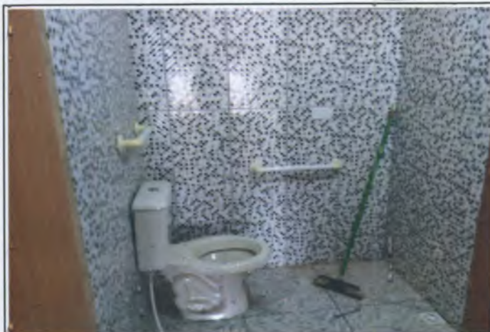
Foto 02: Banheiro térreo com adaptações de acessib.
