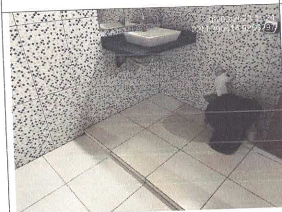
Figura 7 - Vista Interna - Banheiro da Suíte 01. O imóvel possui um banheiro adequado, com cerâmica nos pisos e parede, também forrada. Não foi encontrado nenhum problema patológico.
