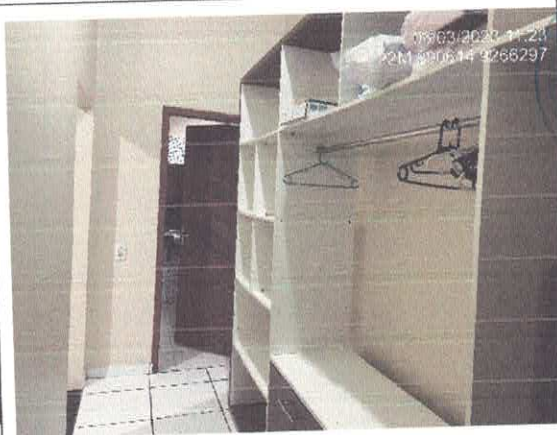
Figura 6 - Vista Interna - Closet da Suíte 01. Edificação com um bom acabamento interno, possuindo alguns mobiliários para locação.
