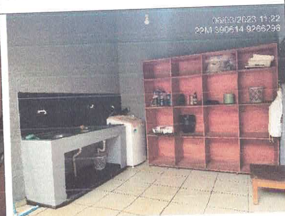
Figura 10 - Vista Externa - Área de Serviço. Nessa região o piso é de cerâmica, rebocada e pintada. Não possuindo nenhum problema patológico.
