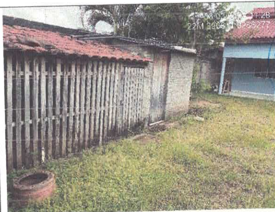
Figura 12 - Vista Externa - Área da frente. Encontra um casa de maquinas e um casinha para cachorro. Também encontra a varanda coberta. Algumas paredes em madeira e outras e alvenaria chapiscada.
