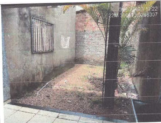
Figura 11 - Vista Externa - Área do Terreno. Nesse local algumas paredes encontram-se rebocada e outras apenas chapiscada. Contendo vegetação e sem piso.
