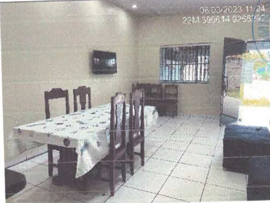
Figura 2 – Vista interna - Sala de Estar, piso revestido de cerâmica, rebocada, pintada e forrada, caracteriza um padrão alto de acabamento.
