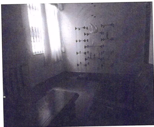
FOTO 16 ÁREA DE ACOLHIMENTO 2º PAVIMENTO
