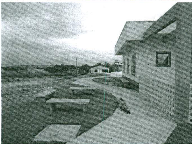
Vista lateral do prédio da Creche JK
