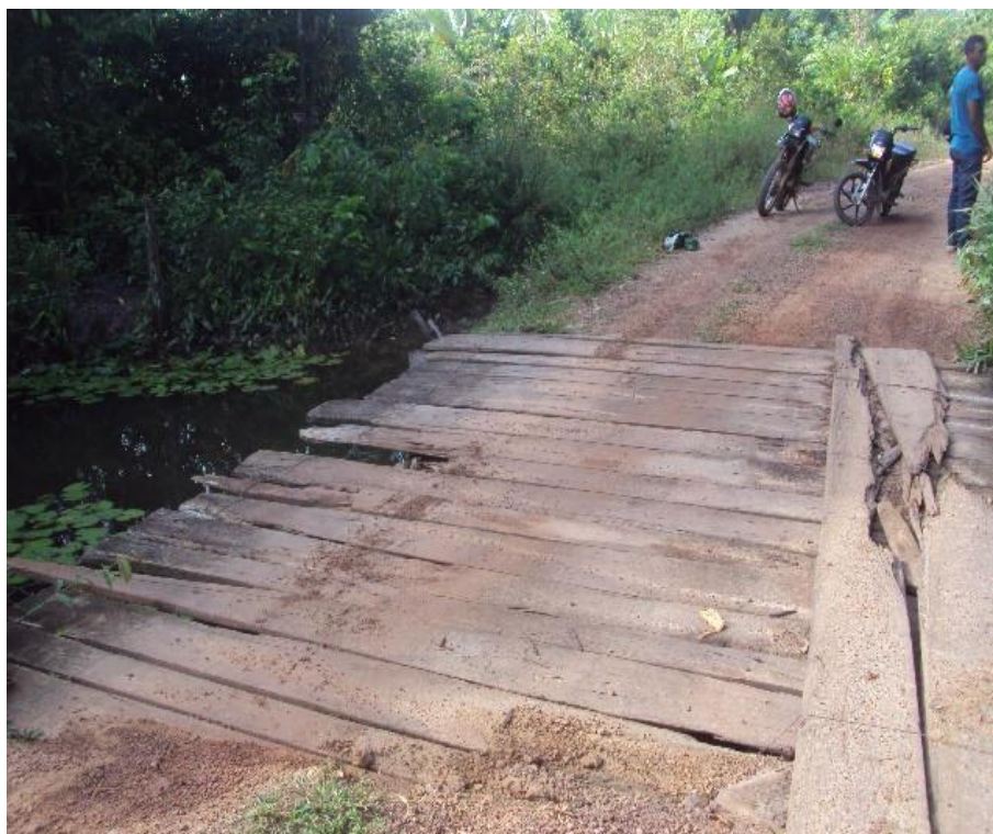
Figura 01: Vista superior de ponte de 5m de extensão sobre o Igarapé do “Preto”
