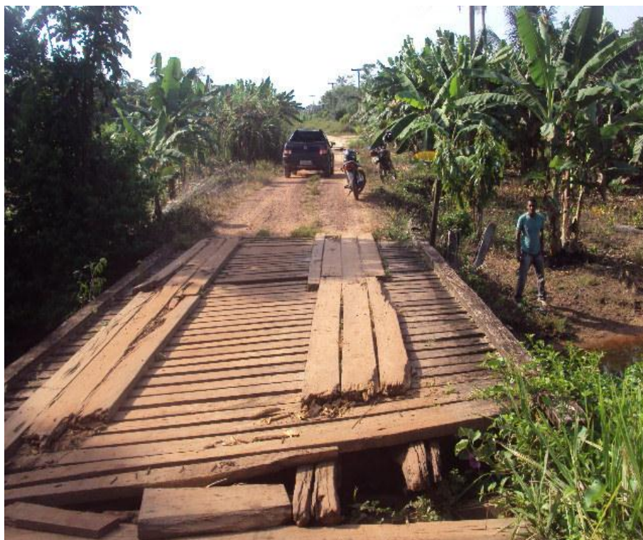
Figura 01: Vista superior de ponte de 8m de extensão sobre o Rio Jutai
