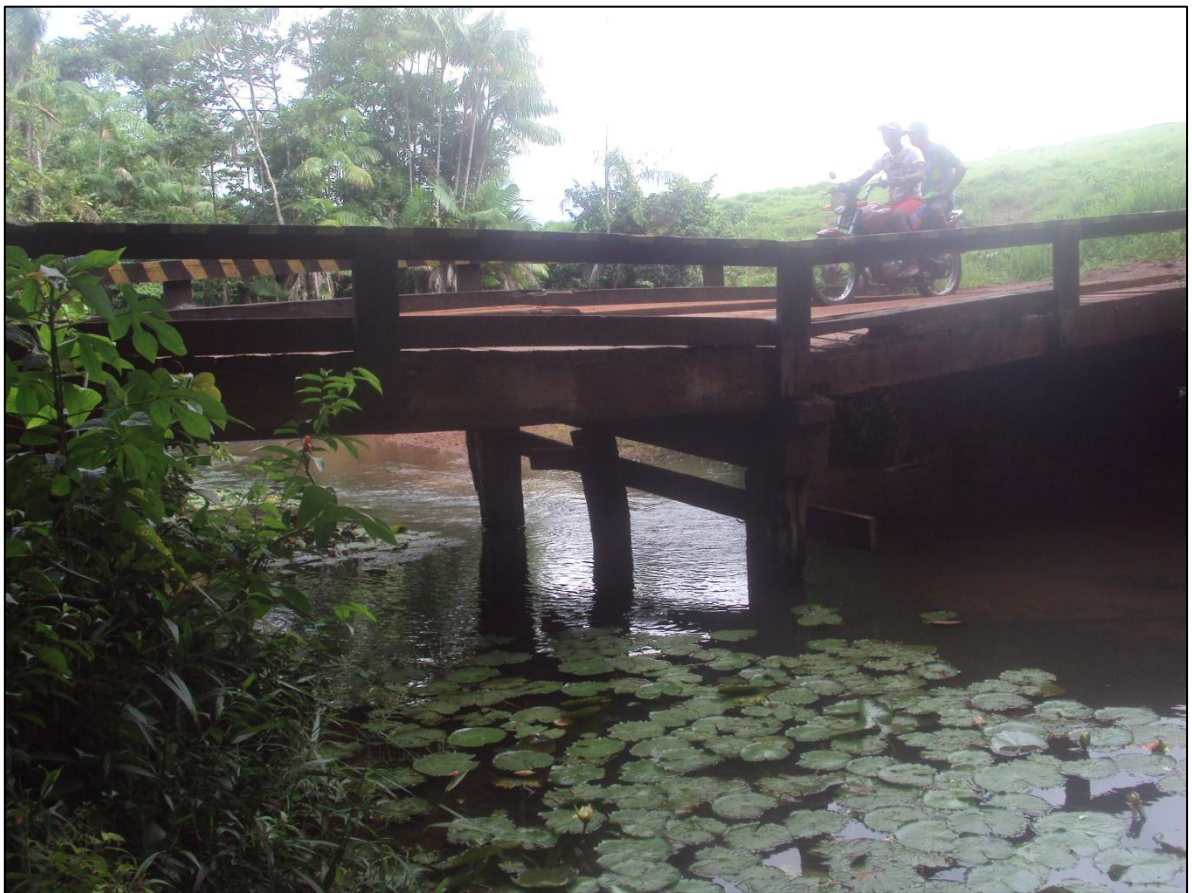
Figura 01: Vista lateral de ponte localizada sobre o igarapé Aracutéua
