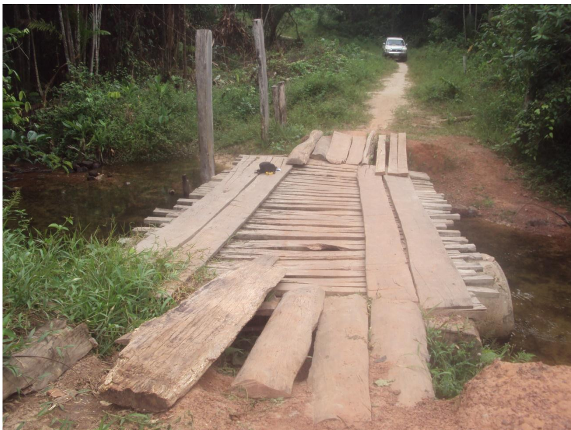
Figura 01: Vista superior de ponte localizada no Km 07 do Ramal da Raimundona
