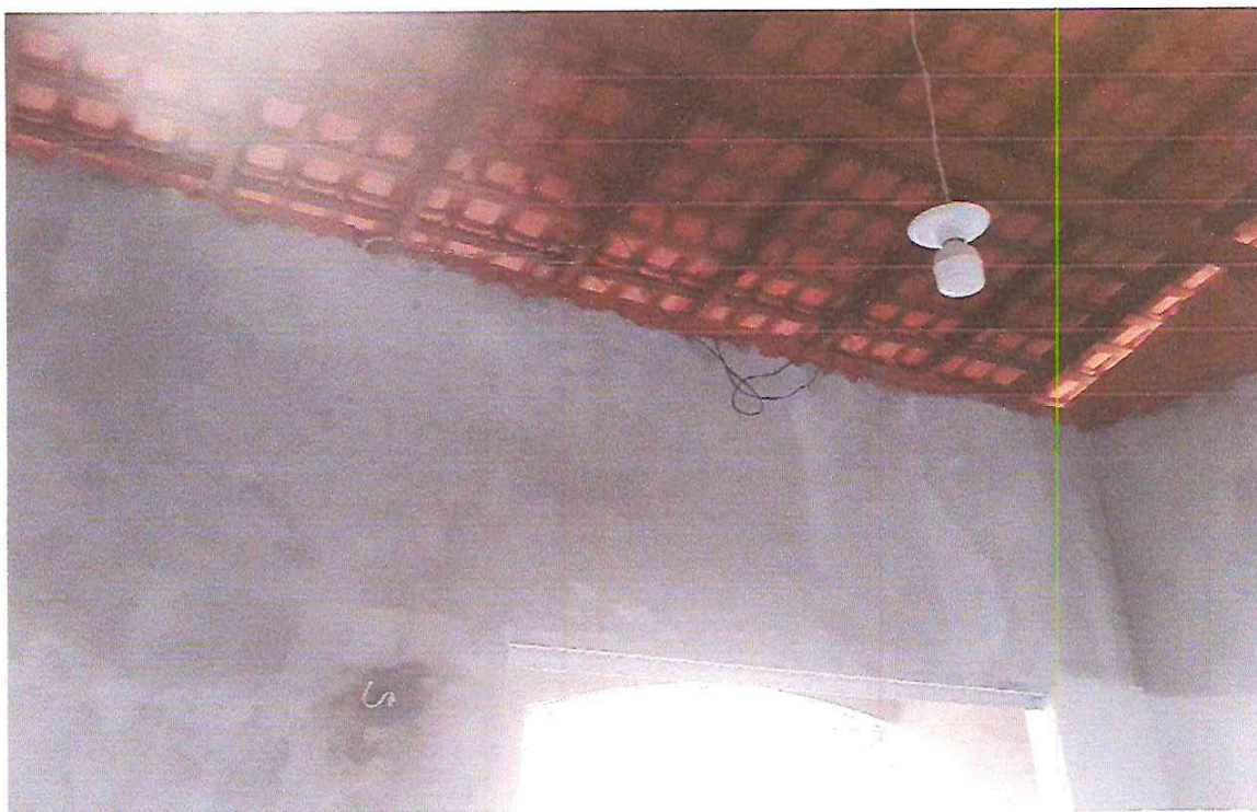
FOTO 06: COBERTURA TELHA CERÂMICA (AMBIENTE NÃO APRESENTA FORRO).
