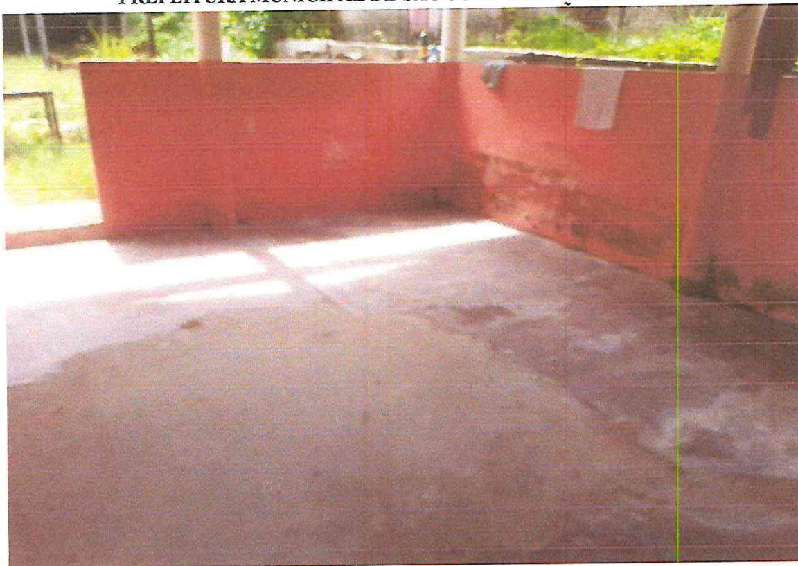
FOTO 09: ÁREA COBERTA – PISO CIMENTADO.
