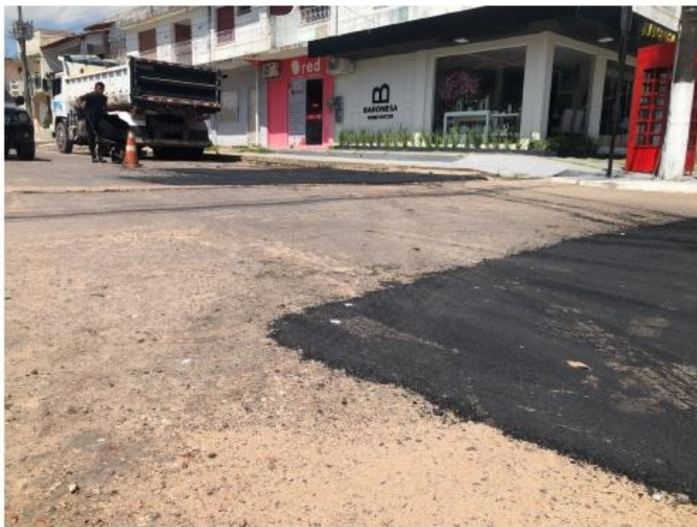
Equipes realizam manutenção asfáltica e demais trabalhos
