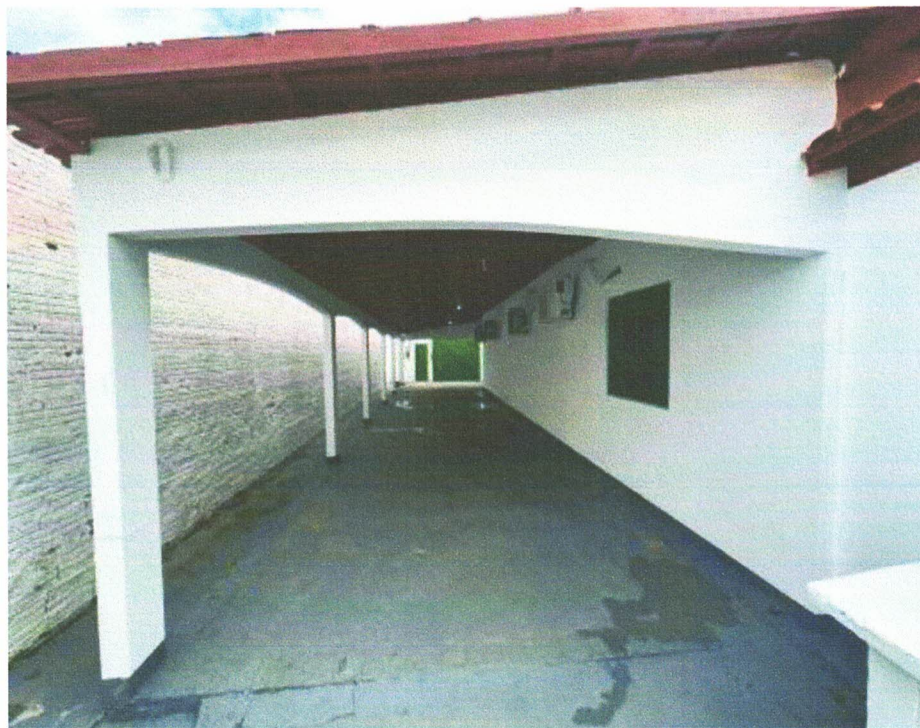
Figura 10: Garagem e circulação de veículos e pessoas, com acesso direto ao portão frontal.
