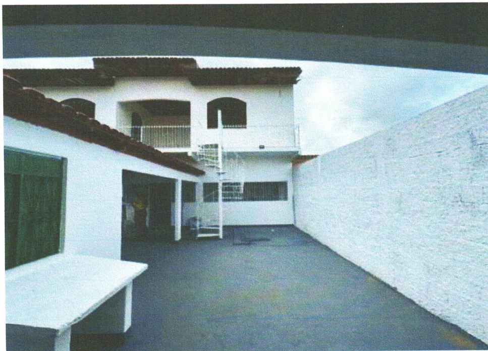
Figura 9: Área externa de uso múltiplo e pavimento superior com escada e guarda corpo metálico.
