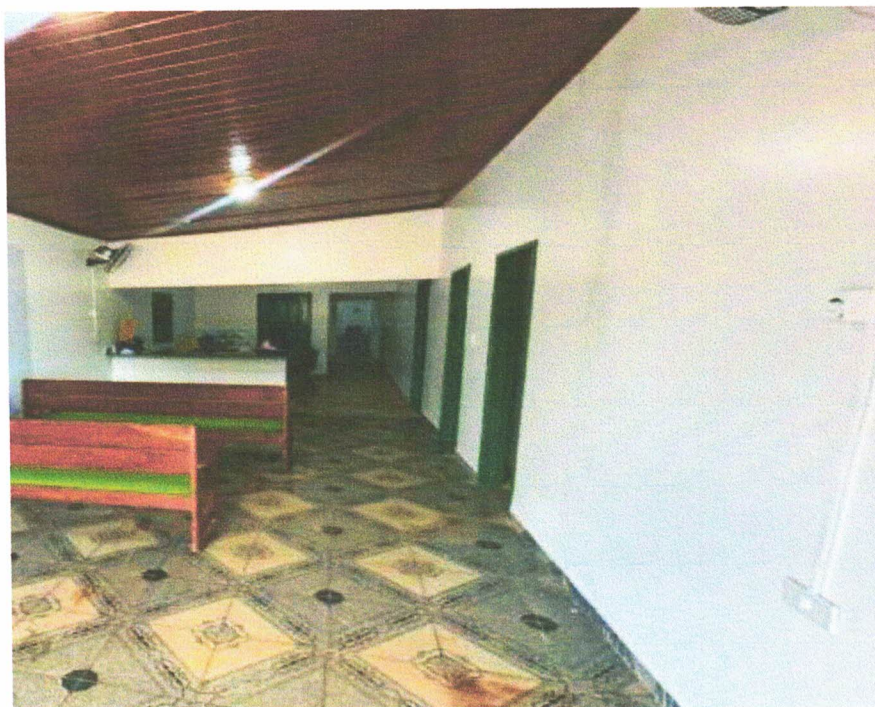
Figura 1: Área de recepção, apresenta piso em revestimento cerâmico e forro em lambris de madeira.
