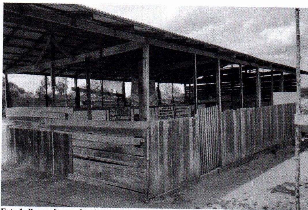
Foto 1: Barracão que funciona a Escola Beira
