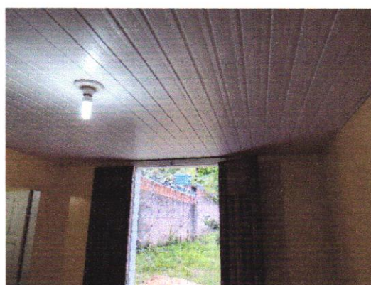
Foto 10 – Vista do forro.
