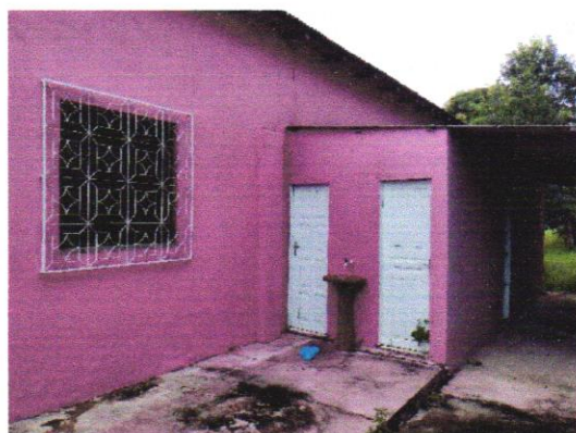
Foto 11 – Pia e banheiros externos.
