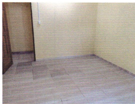
Foto 14 – Vista do piso de sala.
