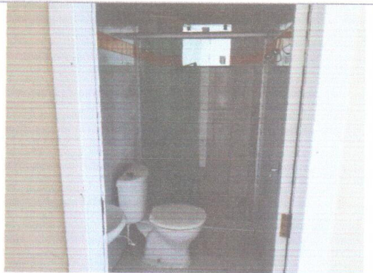
Foto: 09 - Imóvel Pav1 banheiro.
