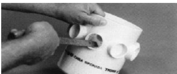
Arremate nas caixas
