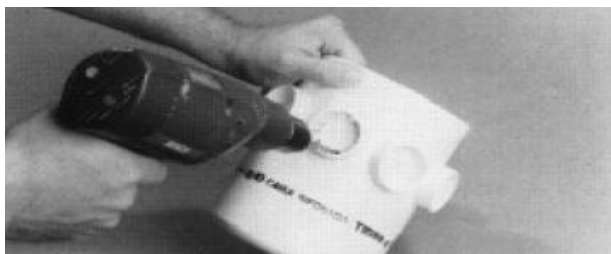
Abertura dos furos nas caixas sifonadas.
