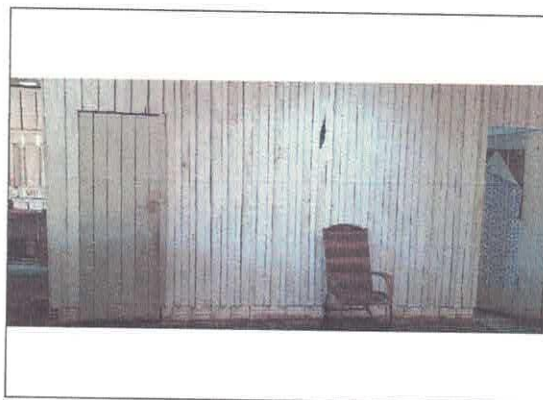
Imagem 06: POSTO DE SAÚDE: Vista interna
