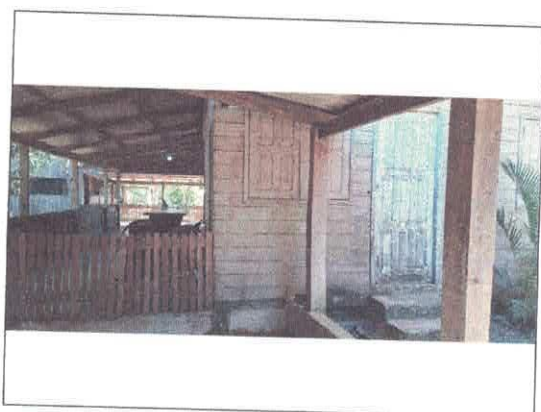
Imagem 07: CASA DE APOIO: Vista interna
