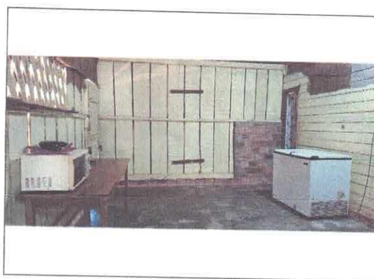
Imagem 10: CASA DE APOIO: Vista interna
