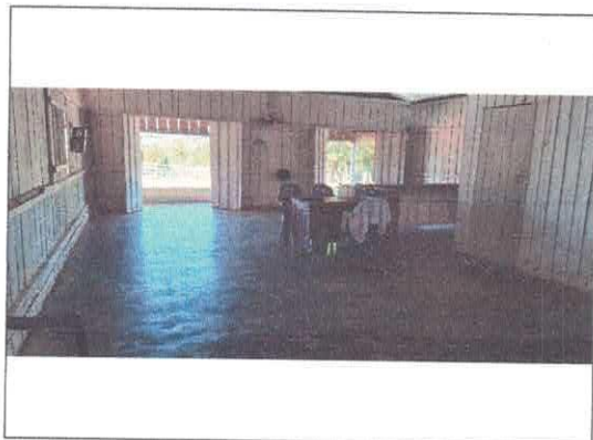
Imagem 05: POSTO DE SAÚDE: Vista interna
