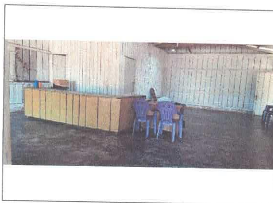
Imagem 04: POSTO DE SAÚDE: Vista interna
