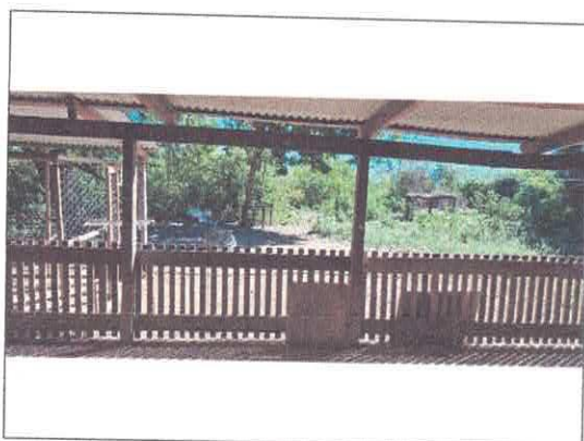
Imagem 09: CASA DE APOIO: Vista interna
