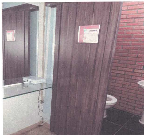
FOTO DO BANHEIRO FEMININO
