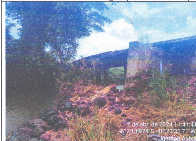
Imagem 03 – Ponte de madeira sobre o Igarapé Axixá, com cerca de 24 metros de extensão com estrutura de base parcialmente comprometida pela força de corrente de água pluvial, principal via de escoamento de produtos alimentícios produzidos na Zona Rural.
