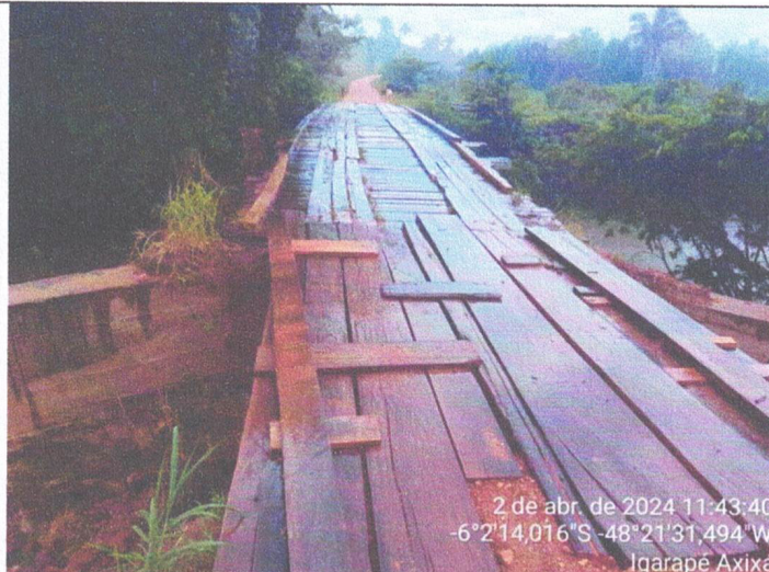
Imagem 02 – Instalação de tábuas de madeira para reestabelecimento provisório do tráfego no local totalmente interrompido após carreamento do aterramento de cabeceira da Ponte sobre o Igarapé Axixá.
