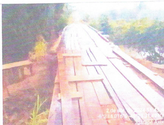
Imagem 02 – Instalação de tábuas de madeira para reestabelecimento provisório do tráfego no local totalmente interrompido após carreamento do aterramento de cabeceira da Ponte sobre o Igarapé Axixá.
