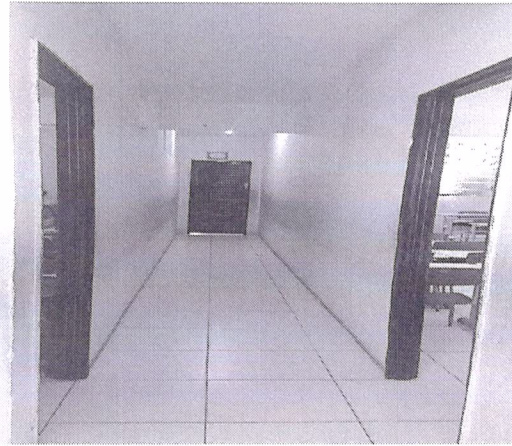
FOTO 08 : ÁREA DE CIRCULAÇÃO
