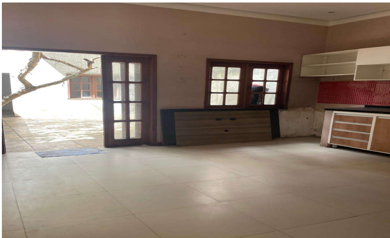
Figura 06 – Construção de parede em alvenaria, para isolamento da cozinha e instalação de revestimento cerâmico nas paredes até 1,50m.
