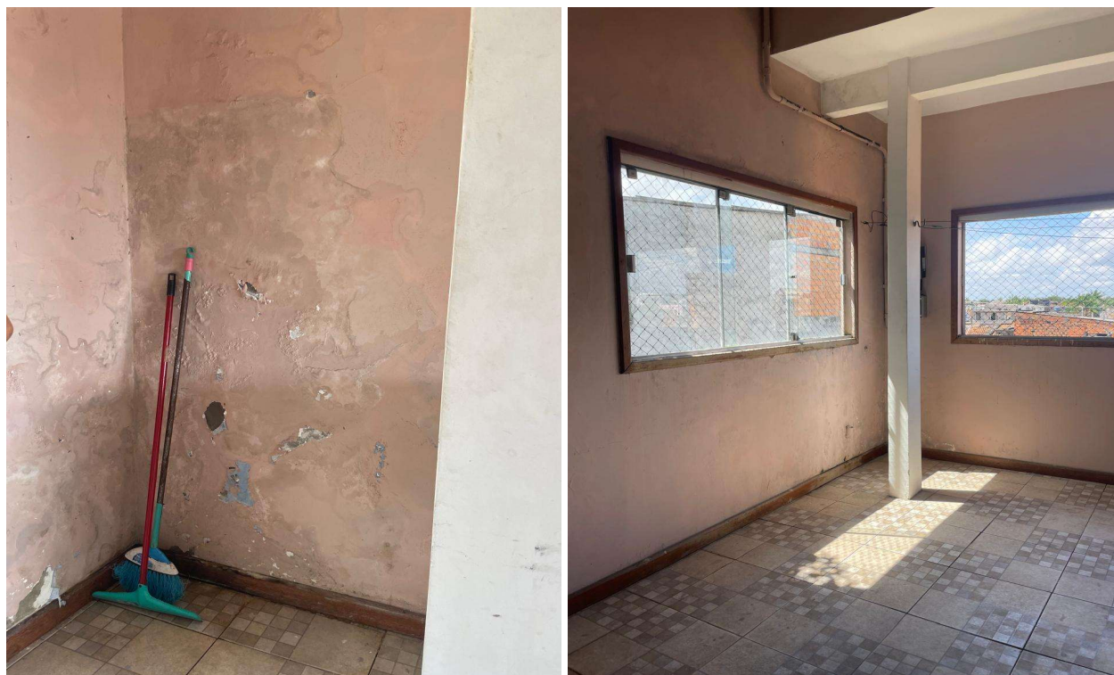
Figura 03 e 04 – Tratamento de infiltrações
