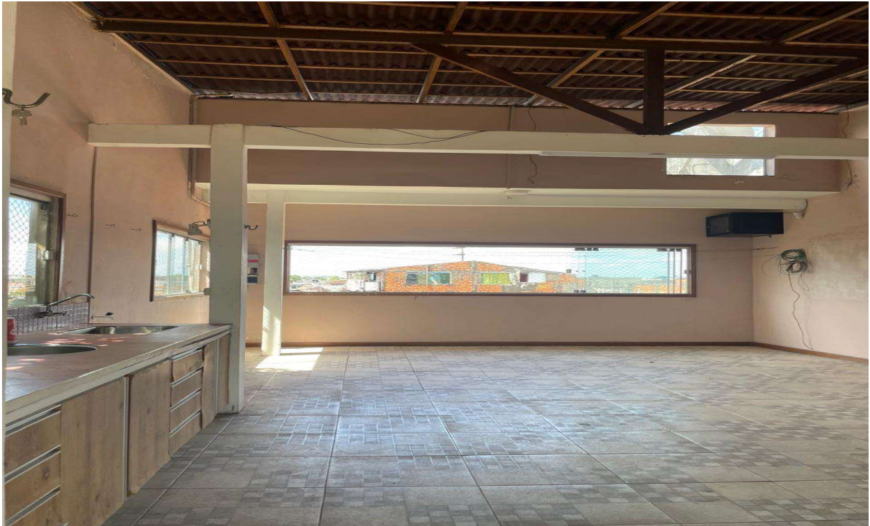
Figura 07 – Instalação de forro em PVC.
