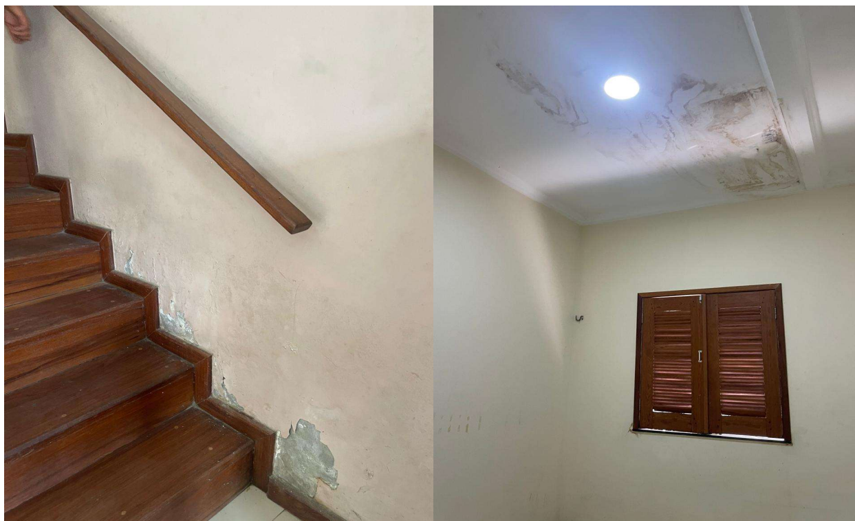
Figura 01 e 02 – Tratamento de infiltrações
