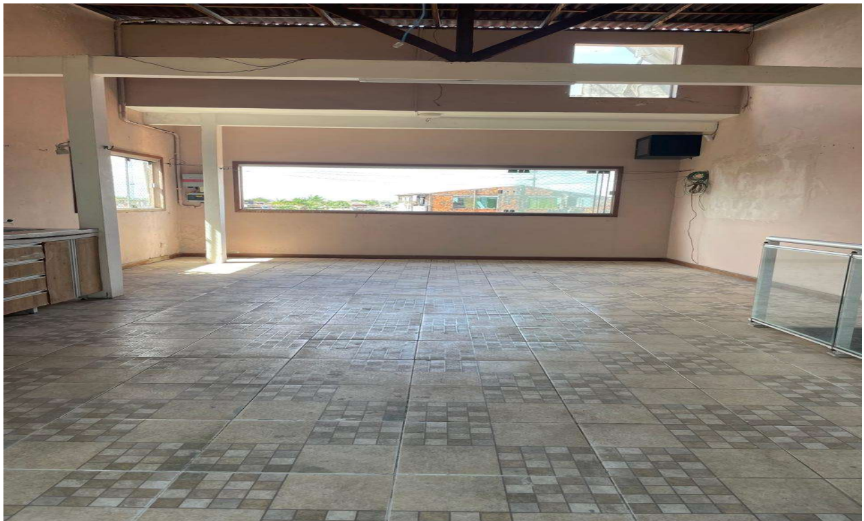
Figura 09 – Instalação de divisórias (SEMEC).
