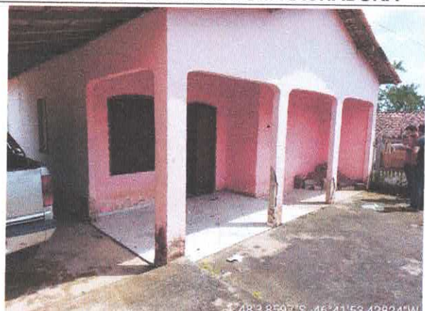
FOTO 010 – PILARES COM RACHADURA
