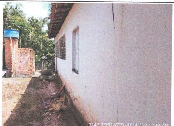
FOTO 04 – LATERAL DA CASA
