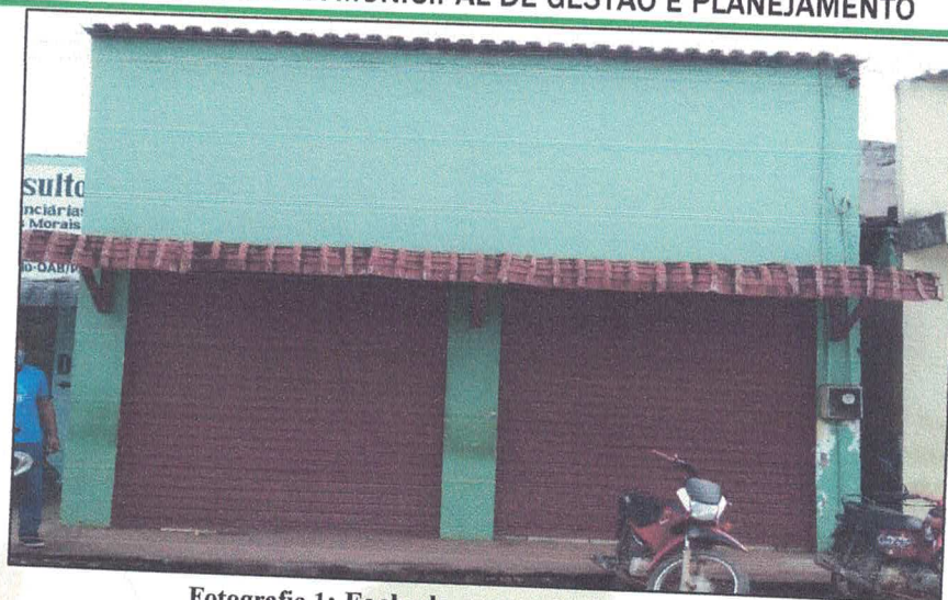
Fotografia 1: Fachada e entrada da edificação.
