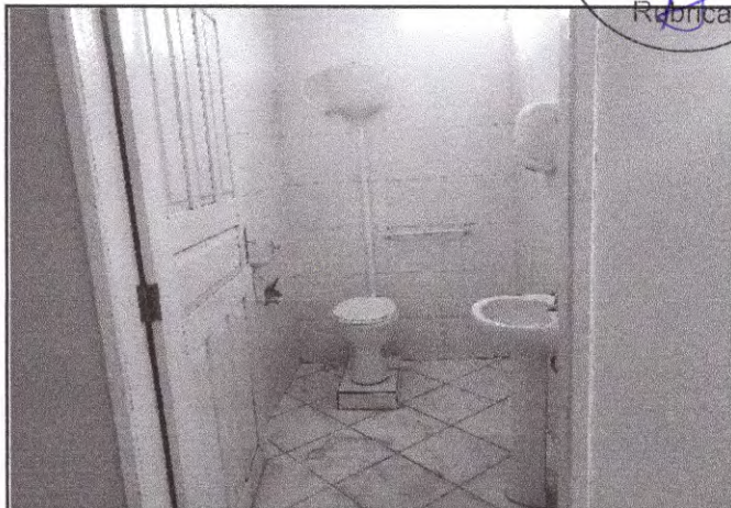
Foto 08: Banheiro com lavatório em louça, torneira metálica e vaso em louça branca com caixa de descarga em plástico.
