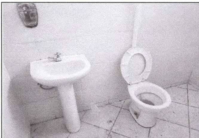
Foto 09: Banheiro com lavatório em louça, torneira metálica e vaso em louça branca com caixa de descarga em plástico.
