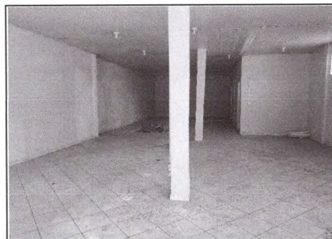
Foto 05: Vista interna do imóvel com piso cerâmico e forrado por forro PVC.
