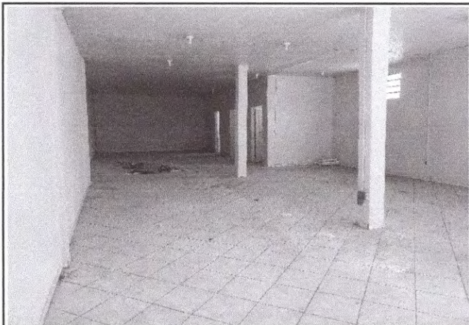
Foto 07: Vista interna do imóvel com piso cerâmico e forrado por forro PVC.
