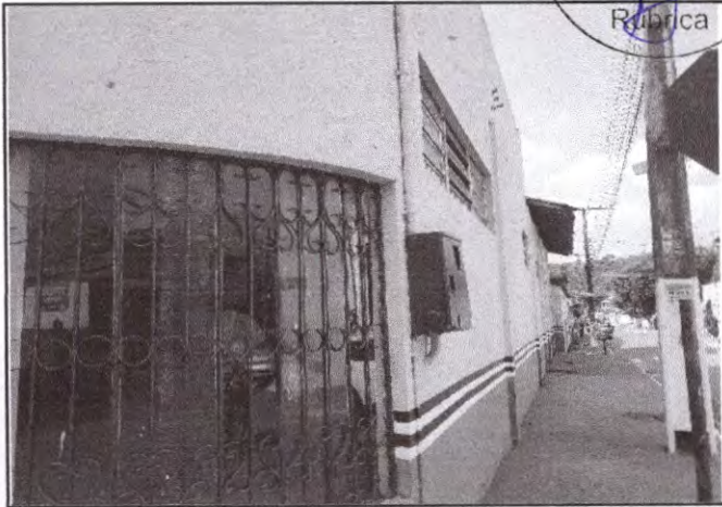
Foto 02: Janelas tipo grade em ferro e vidro.
