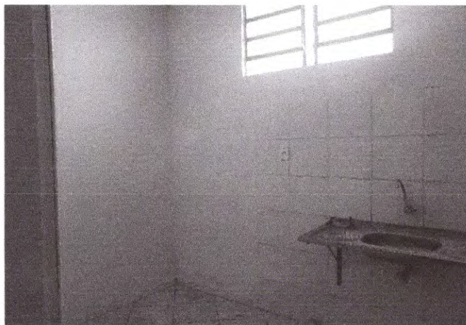
Foto 13: Copa com pia em aço inox e torneira metálica.
