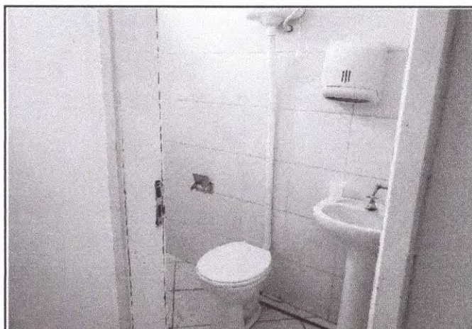
Foto 10: Banheiro com lavatório em louça, torneira metálica e vaso em louça branca com caixa de descarga em plástico.
