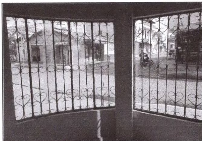
Foto 03: Janelas tipo grade em ferro e vidro.
