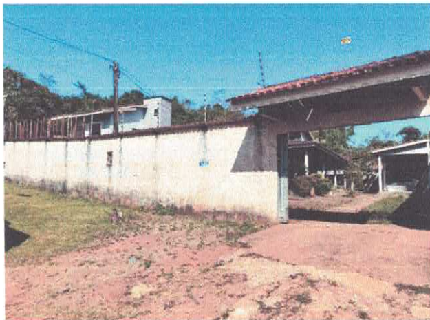
Imagem 1 - Fachada do imóvel
