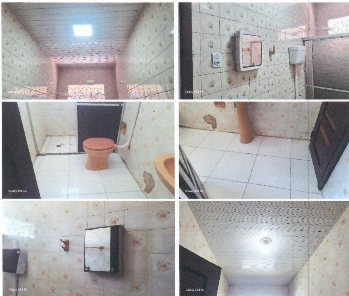
Fotos 25, 26, 27, 28, 29 e 30 – Piso, Forro, Revestimento, Instalações hidrossanitárias dos banheiros, Etc.
