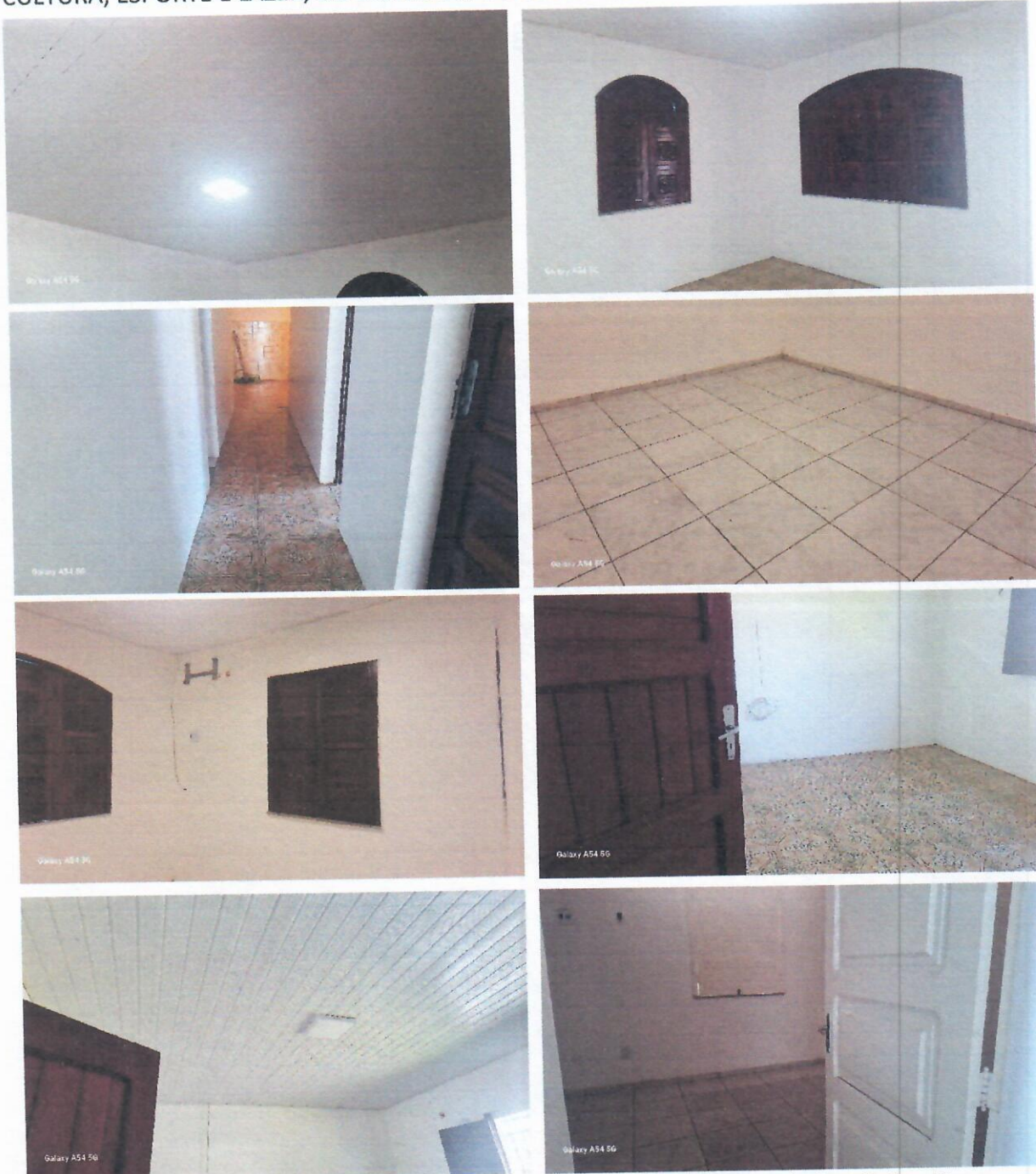
Fotos 09, 10, 11, 12, 13, 14, 15 e 16 – Paredes, Forro, Pintura, Esquadrias, Pisos, Instalações elétricas, Etc.
