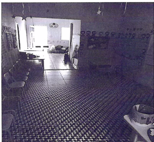
FOTO 01 : SALA DE AULA
