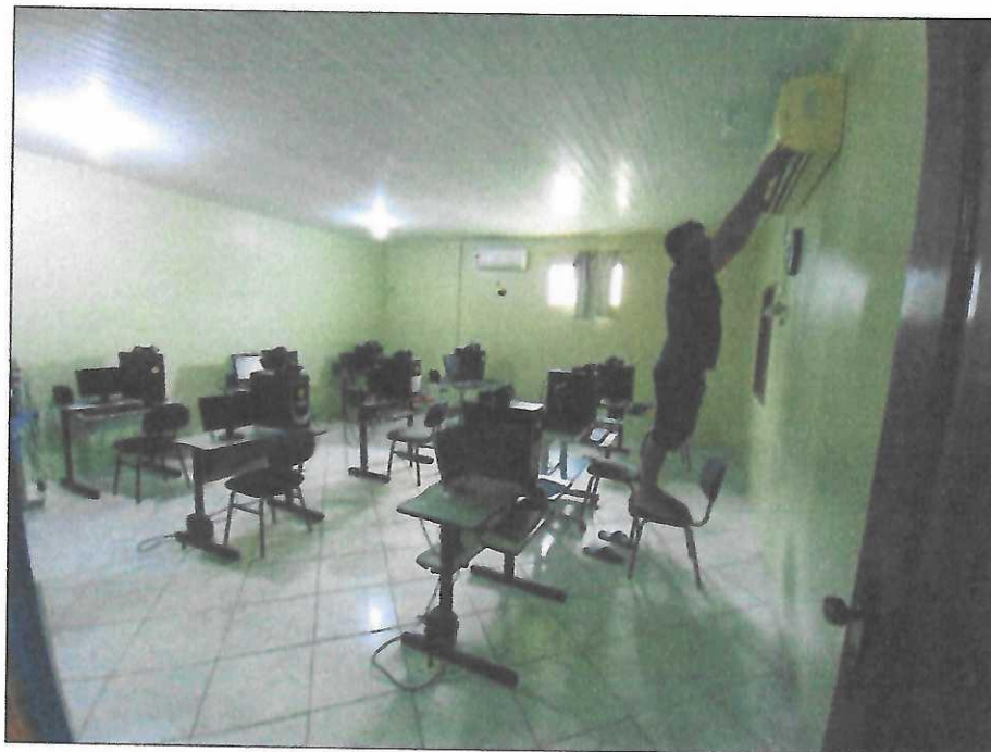
Vista interna Sala de Aula 02.
