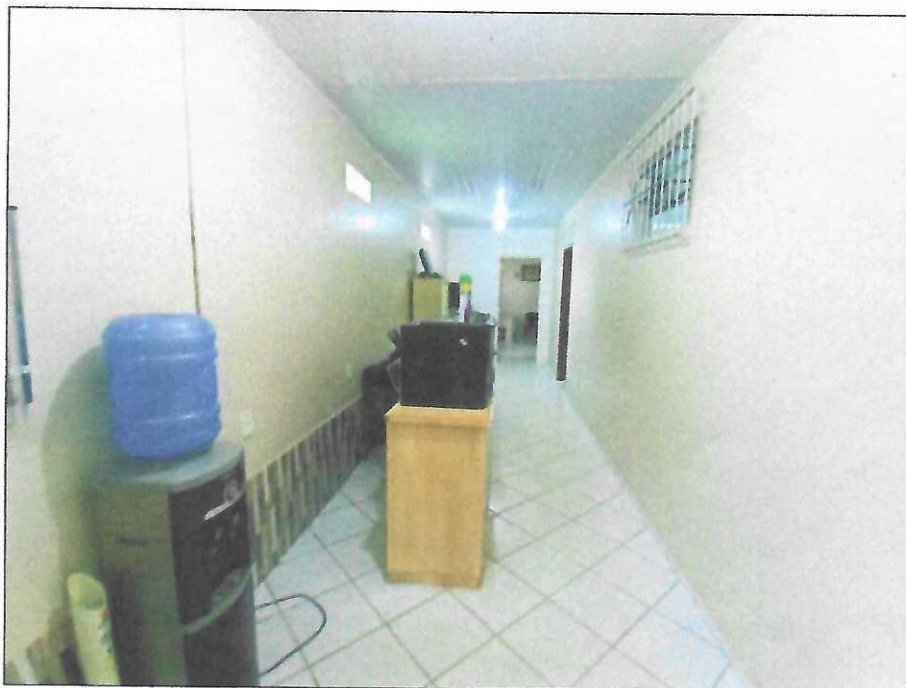
Vista interna corredor de circulação de acesso à escola (Salas de Aula).
