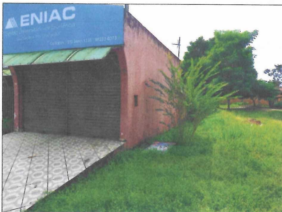
Vista lateral da edificação.
