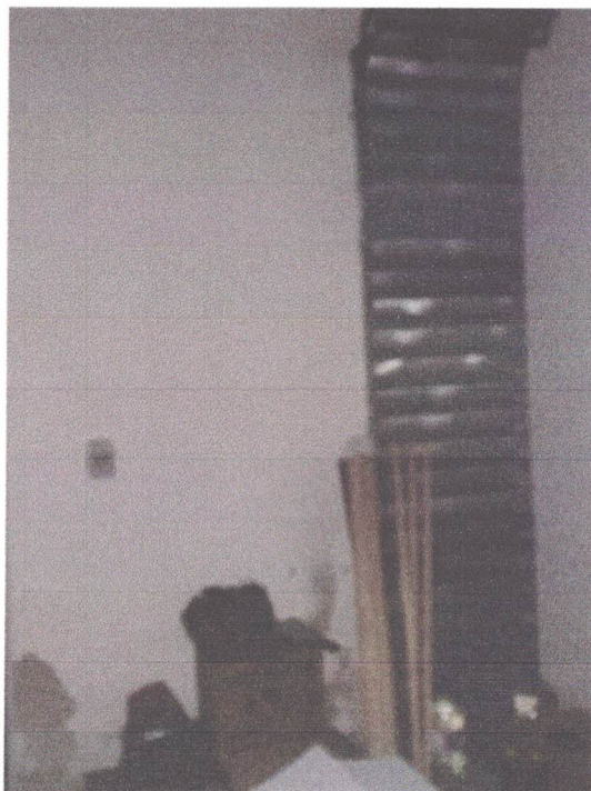
Foto 35: Sala 02, parte do portão de enrolar.
