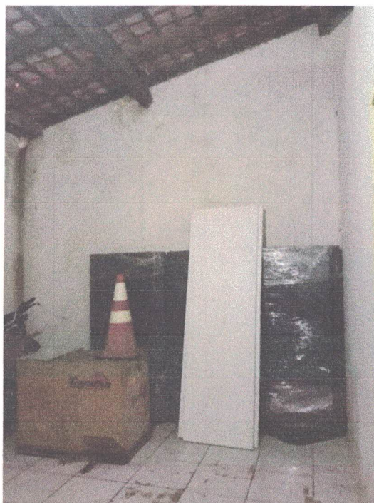
Foto 32: Sala 01, sem forro, cobertura em estrutura de madeira e telhas cerâmicas tipo capa/canal colonial.
