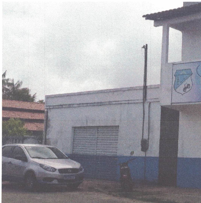
Foto 29: Fachada frontal da edificação anexo.
