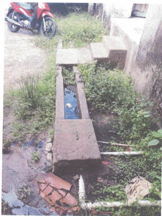
Foto 46: Tubulação exposta, acúmulo de água, caixas de drenagem e necessidade de remoção de vegetação.
