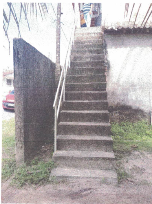
Foto 47: Escada de acesso ao pavimento superior.
