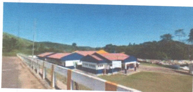
IMAGEM 1 ÁREA EXTERNA ANÁLISE DE COBERTURA
