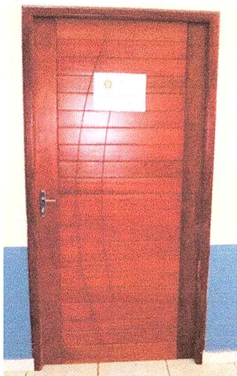
Legenda: Portas em bom estado de conservação.
