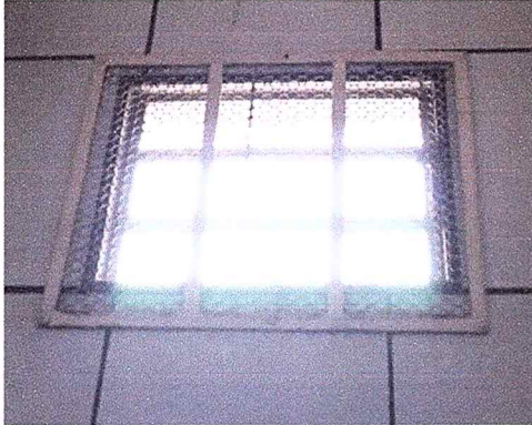
Legenda: Janela banheiro uso interno.
