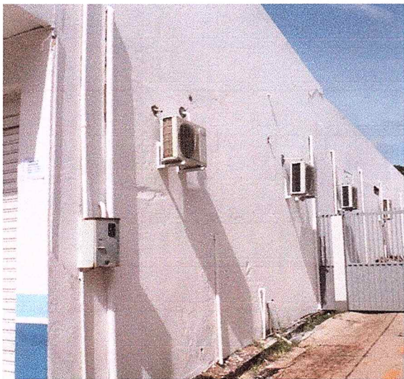
Legenda: Alvenaria externa, em boas condições.
