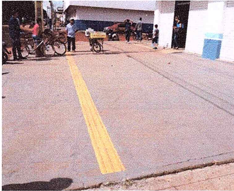
Legenda: Piso externo em boas condições.
