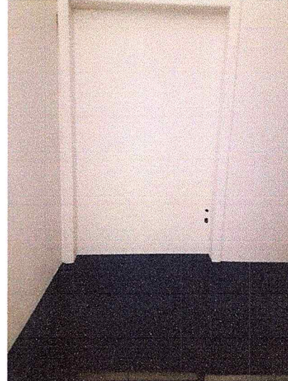
Legenda: Porta em MDF, não se obteve acesso ao interior da sala.
