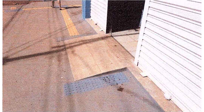
Legenda: Rampa de acessibilidade.
