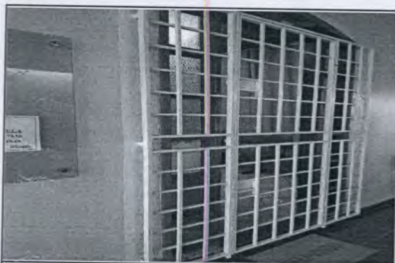
Foto 07: Porta de acesso principal
