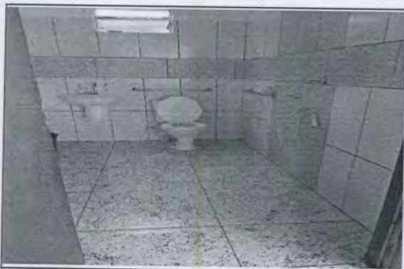
Foto 03: Banheiro adaptado a acessibilidade
