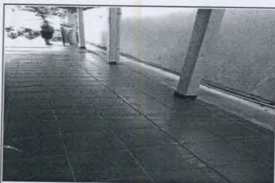
Foto 05: Corredor de acesso
