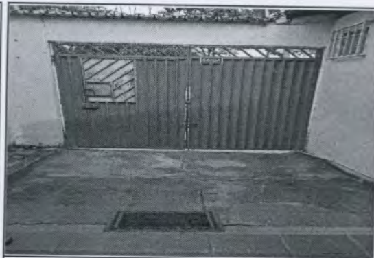
Foto 08: Portão de acesso
