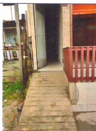
Foto 02: Rampa de acesso
