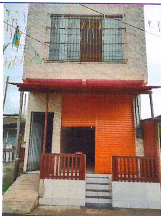
Foto 01: Fachada do imóvel
