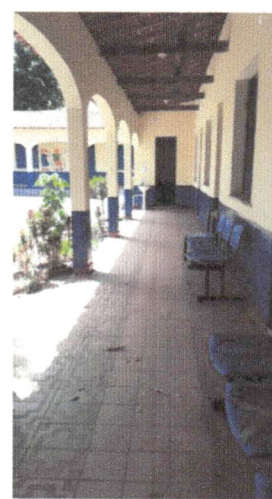
Foto 06: Foto 05: Varanda bloco 02.
